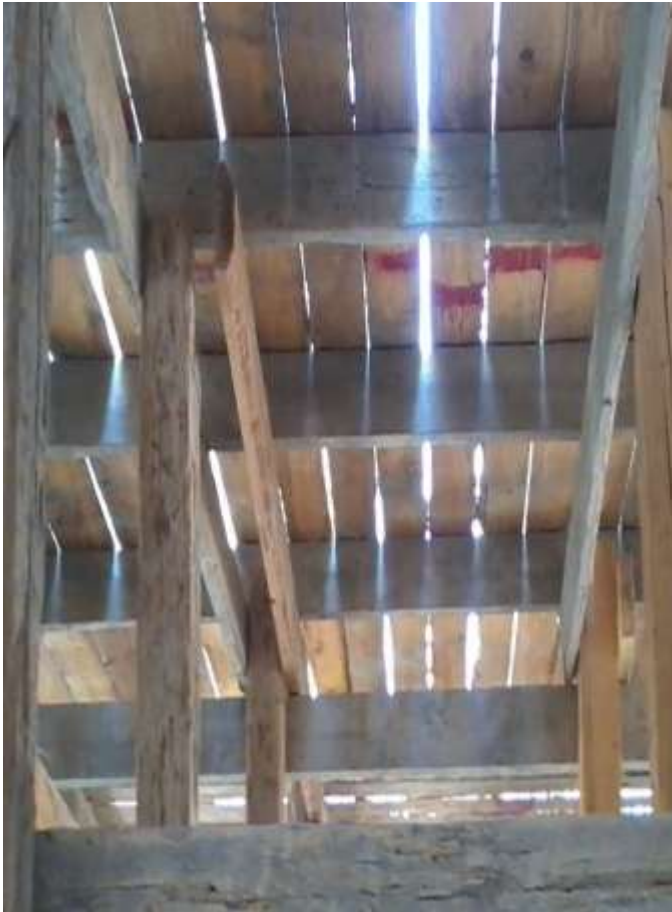
صورة توضح التنوير في السقف وعروق الحبس للكمرات الخارجية
