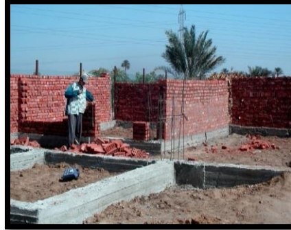
إستخدام الطوب الأحمر أعلى الطبقة العازلة
