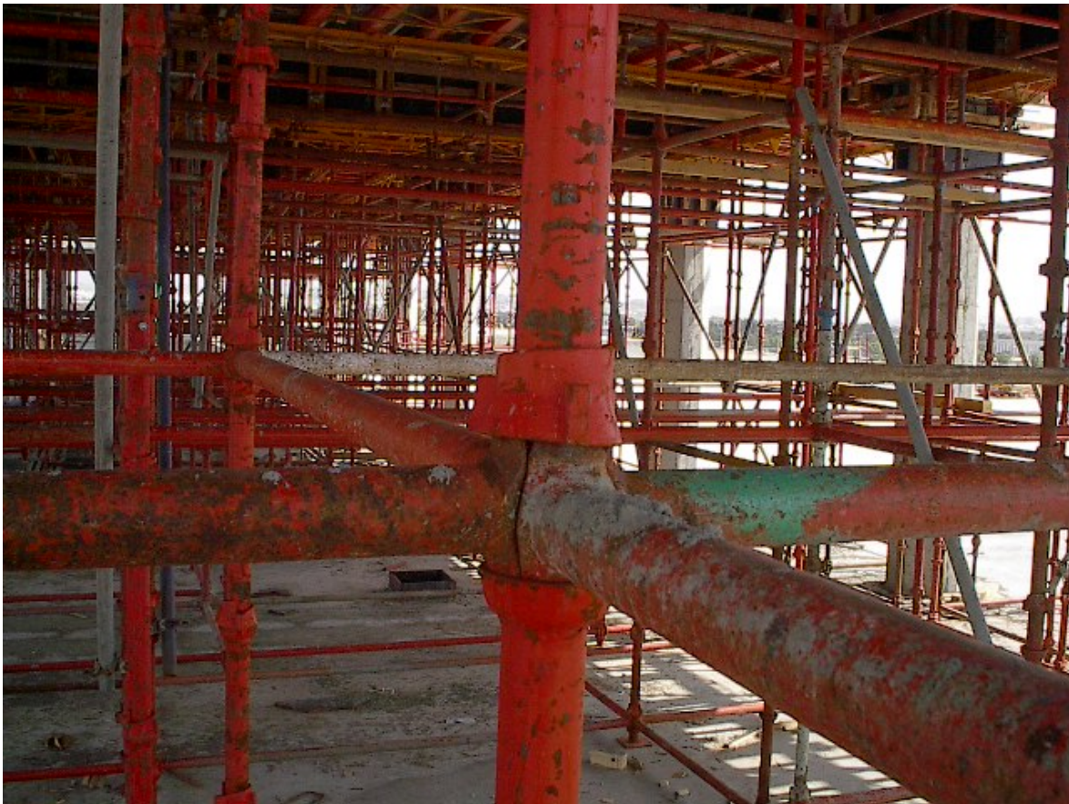
شكل رقم (٨٤) يبين نقاط تجميع العوارض الحديدية
