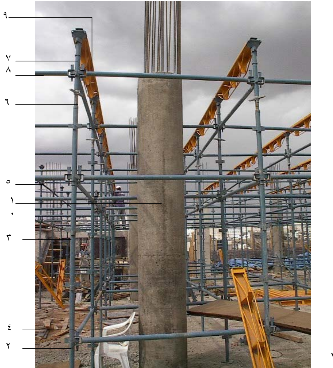
شكل رقم (١٠٢) مكونات تركيب الشدة المعدنية
