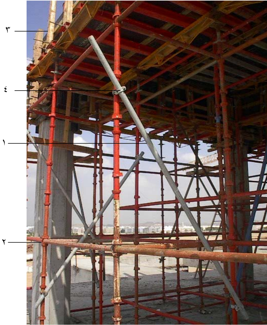
شكل رقم (٩٢) يبين الشكالات الحديدية والتي يجب أن تعطي ارتفاع الشدة
