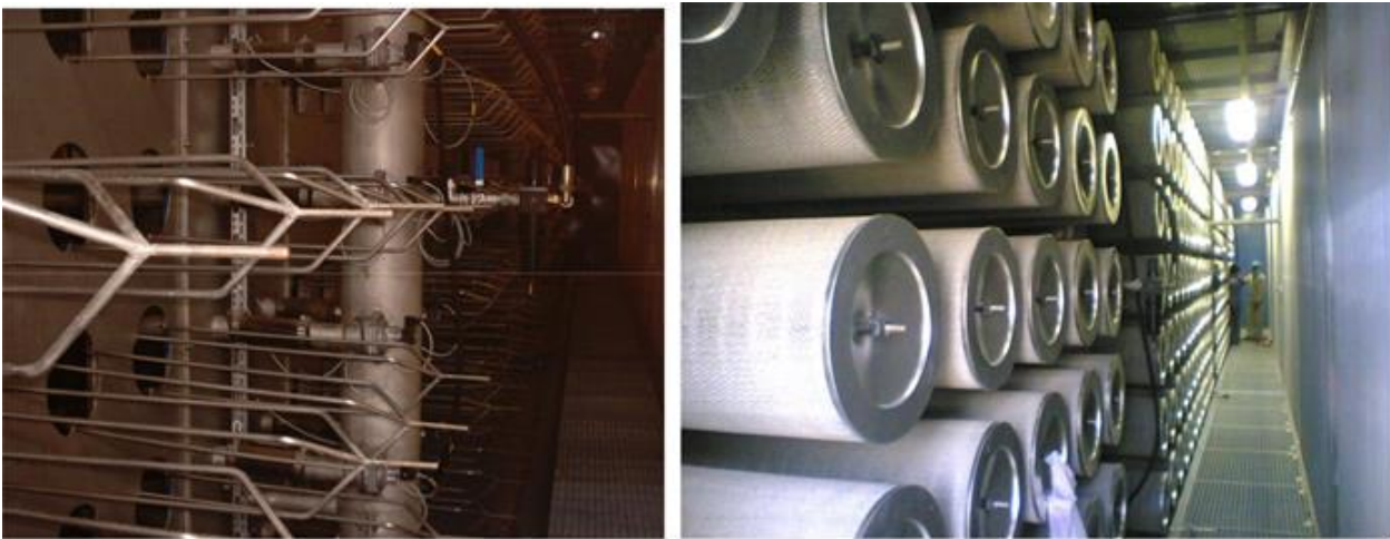
الشكل ( ٣٣ ) بيت فلاتر أو مرشحات مدخل الهواء Air intake filter house من الداخل يظهر عناصر تصفية الهواء قبل وبعد التثبيت ( التركيب ) والثقب وراء كل فلتر هو لخروج الهواء المصفى
