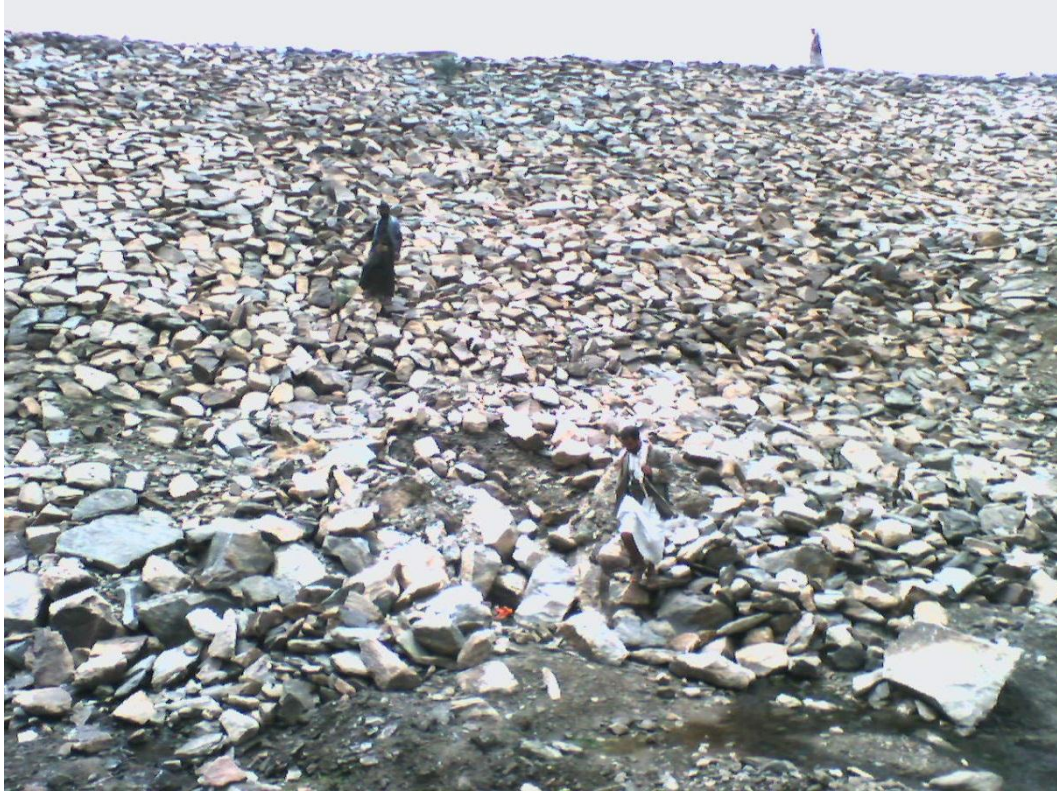
الشكل (٢٢-٤) حماية حجرية رص يدوي hand placed rock riprap
