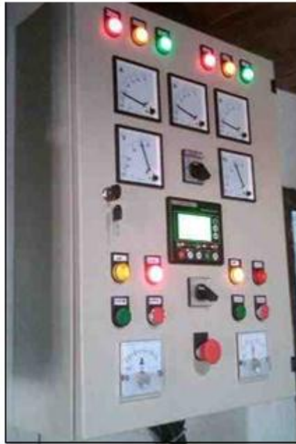
الشكل رقم (٢٢) : لوحة التوزيع
