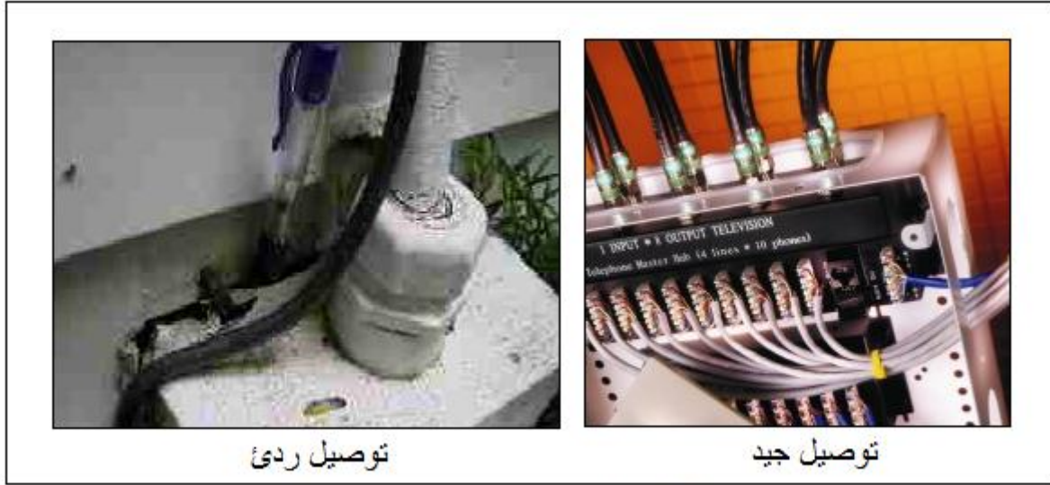
الشكل رقم (٤٩) طرق توصيل الأسلاك
