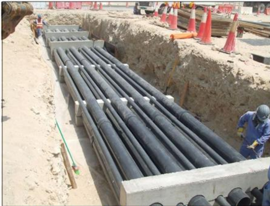
الشكل رقم (١٢) : تجهيز مجارى الكابلات ومواسير الحماية
