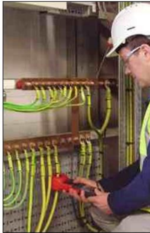
الشكل رقم (٥٠) : فحص أرضى اللوحة
