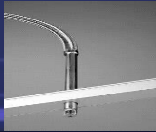
رشاشات الحريق المتصلة بخراطيم مرنة موزعة على السقف على مسافات مناسبة
