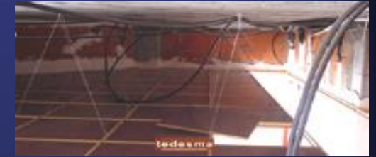
الفراغ بين السقف المعلق والسقف الأصلي ويظهر به التمديدات الكهربائية والكابلات التي ترفع السقف المعلق
