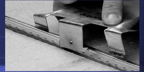
تثبيت اللوح المعدني في شبكة السقف
