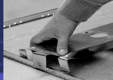
تثبيت اللوح المعدني في شبكة السقف
