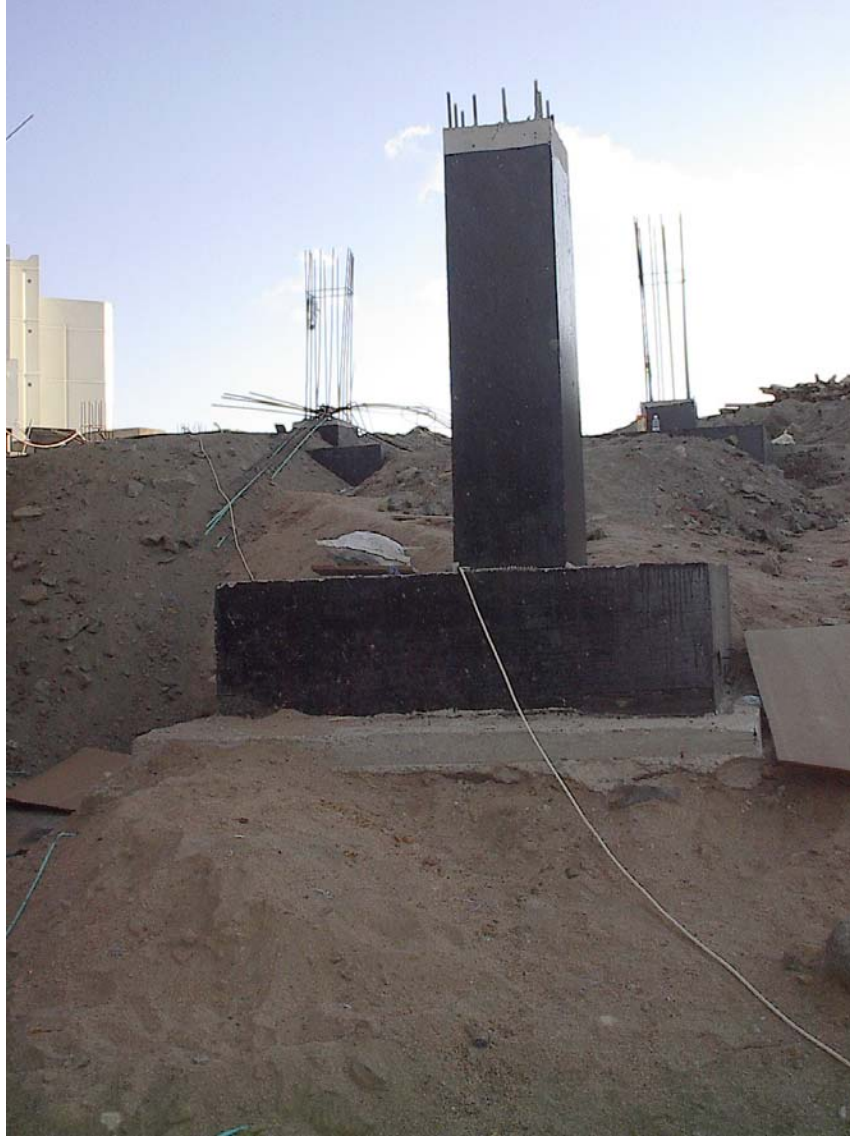
شكل رقم (٣٩) أعمال عزل القواعد ورقاب الأعمدة بالبيتومين المؤكسد الساخن
