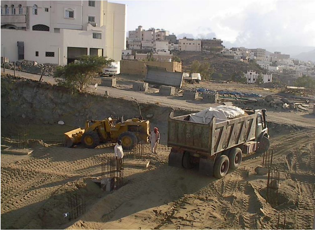
شكل رقم (٨) أعمال الحفر والردم في أحد المشروعات
