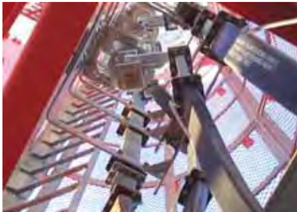
شكل (11): استخدام أدلة الموجة على أبراج الميكروويف
