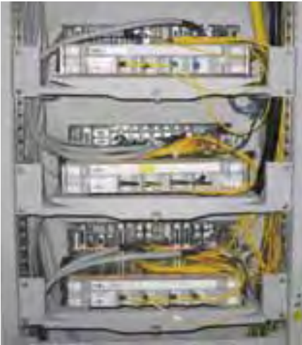
شكل (٣٢) إحدى وحدات ال STM1 الموجودة في قسم التراسل
