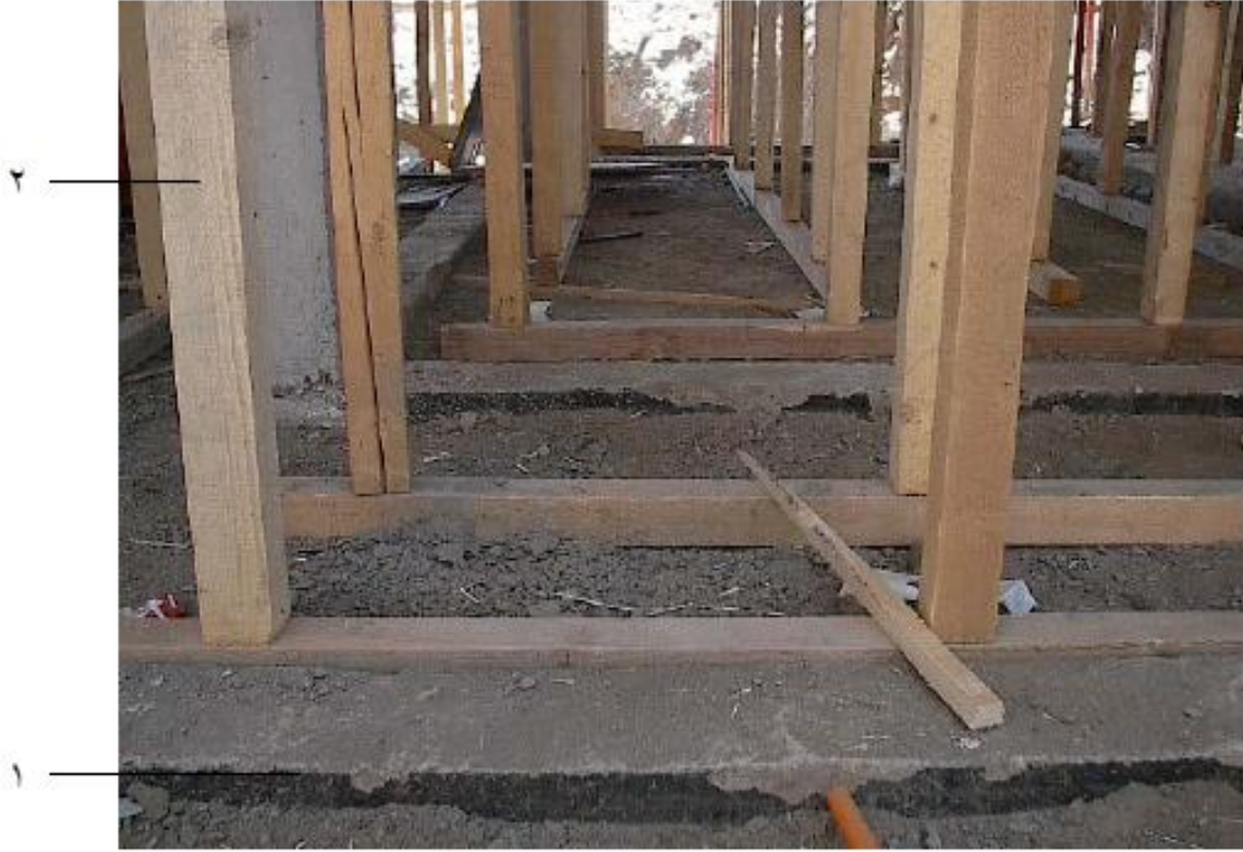
شكل رقم ( ٢٤ ) يبين استخدام العروق الفليري كفرشات أسفل القوائم الرأسية بالدور الأرضي
