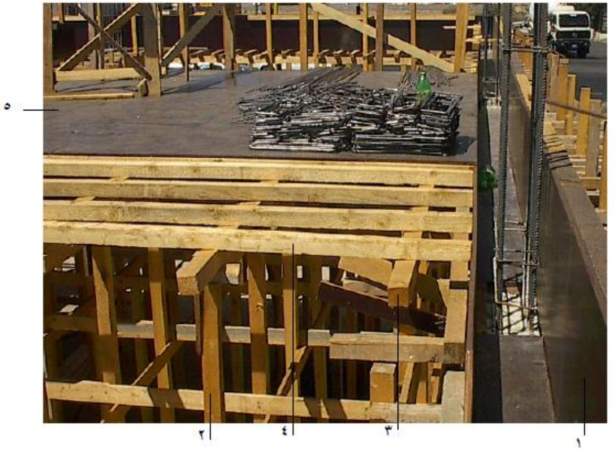
شكل رقم ( ٤٣ ) يبين بدء عملية التطبيق للسقف تمهيدا لعمليات الحدادة
