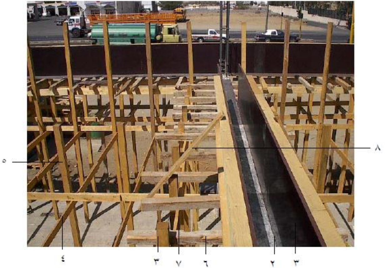
شكل رقم ( ٤٢ ) أعمال التخشب للكمرات
