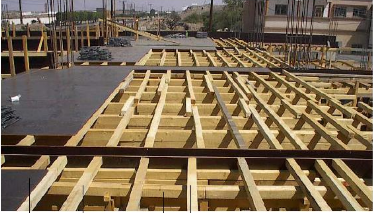
شكل رقم ( ٢٩ ) يبين العرقات في الشدة الخشبية بالسقف ١ - العرقات ٢ - التطاريج ٣ - التطبيق
