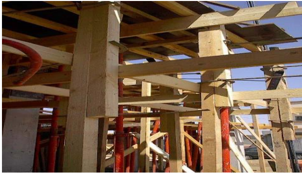
شكل (١٩) يوضح مكونات الشدة للسقف
