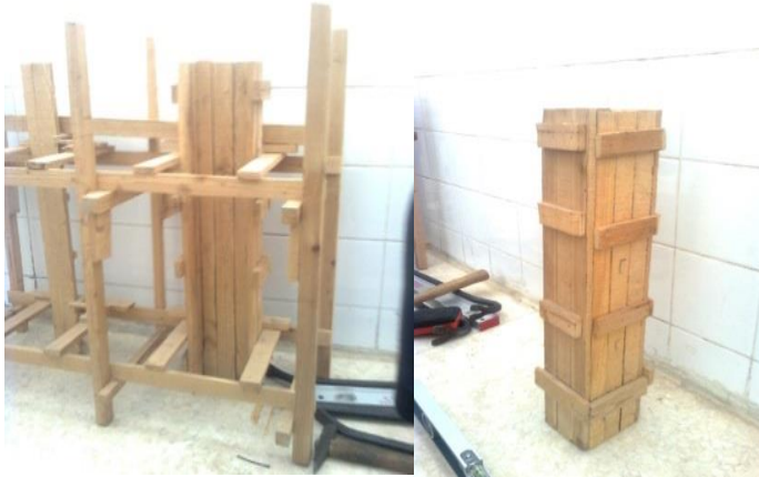
شكل (١٨) يوضح مكونات شدة العمود
