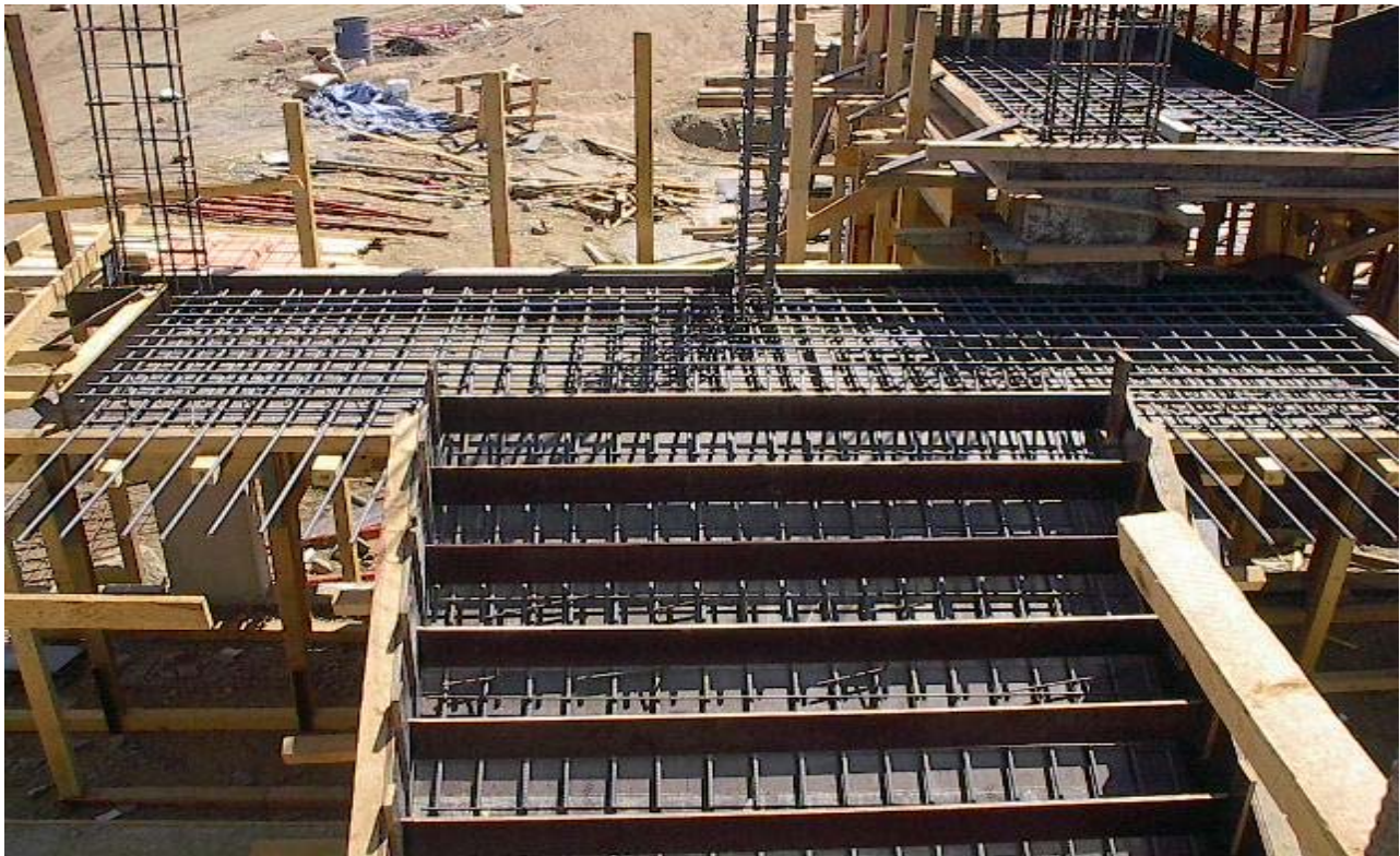
شكل رقم (٨١) يبين تسليح القلبة والصدفة الوسطى
