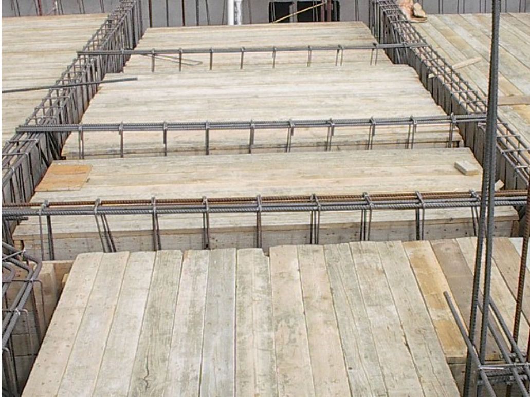
شكل رقم (٧٥) يبين بدء تركيب أعمال الحدادة للكمرات
