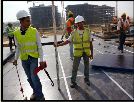
طريقة وزن السقف بالميزان القامة
