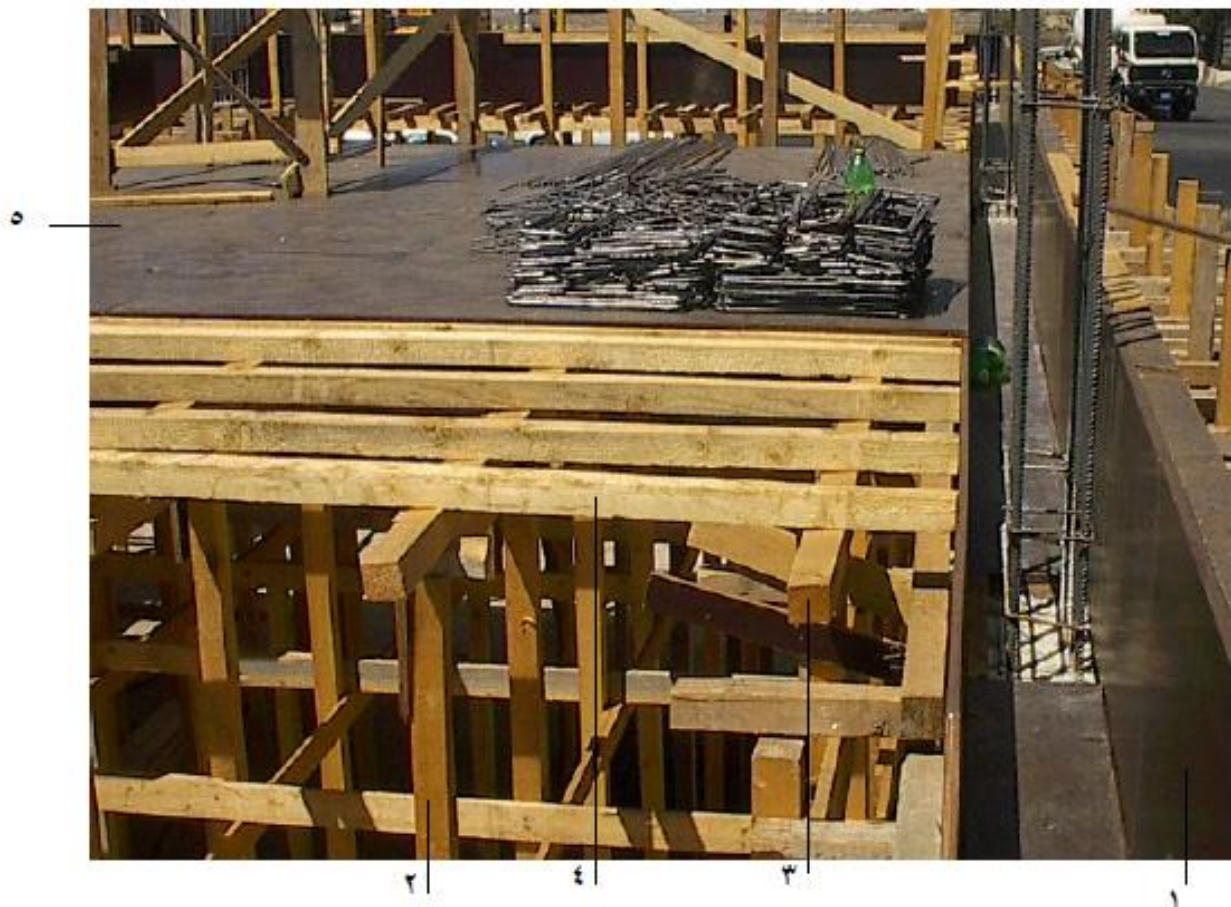
شكل رقم ( ٤٣ ) يبين بدء عملية التطبيق للسقف تمهيدا لعمليات الحداة
