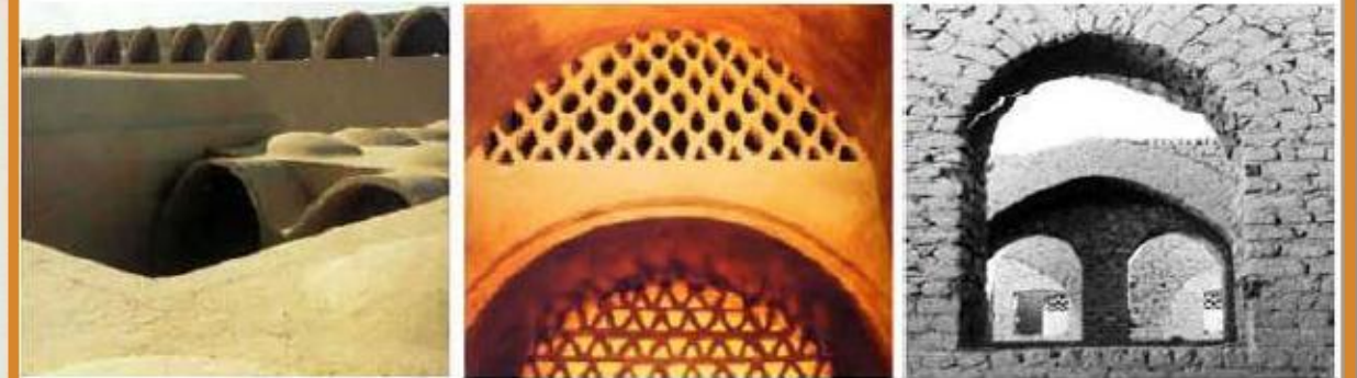
شكل (32155) الملافت الملوية المخصصة بالديوم شكل (32154) قلاع الملافت داخلها لاستقرار الفلق شكل (32153) مواد البناء من الحجر والطوب
