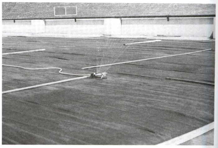
شكل رقم ٥,٢: معالجة الخرسانة بأغشية مبللة بالماء.
