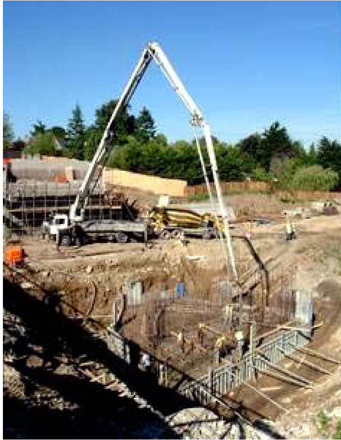
شكل رقم ٣,١: صب الخرسانة من خلال أنبوب بواسطة الضخ.
