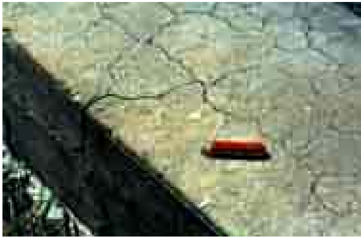
شكل رقم ٧,٣: تشققات في الخرسانة نتيجة ارتفاع كبير للحرارة خلال معالجتها بالبخار.
