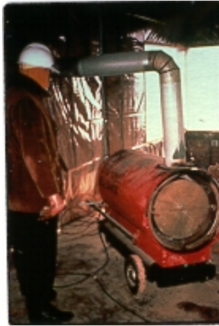
شكل رقم ٤.٥: تزويد الخرسانة داخل المنطقة العازلة بالحرارة.
