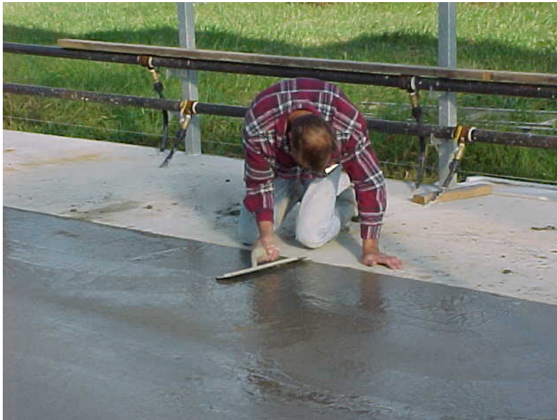
شكل رقم ١٦,١: تهذيب سطح الخرسانة يدويا بواسطة ملاسة.
