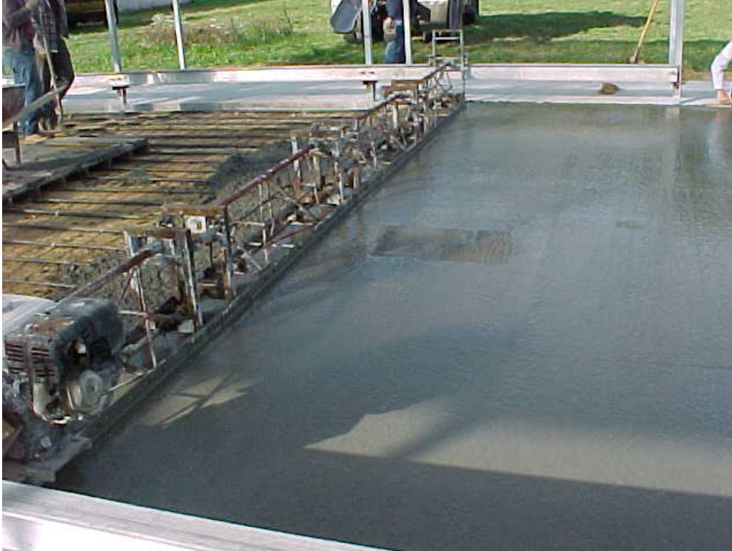
شكل رقم ١٥,١: تهذيب سطح الخرسانة باستعمال آلة ميكانيكية
