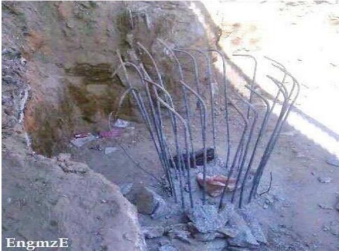
10-ينص الكود المصري على ان يخترق جسم الخازوق الخرسانيه العاديه بكامل سمكها وان يخترق القاعده المسلحه بأرتفاع 10 سم وتترك الاشاير داخل القاعده
