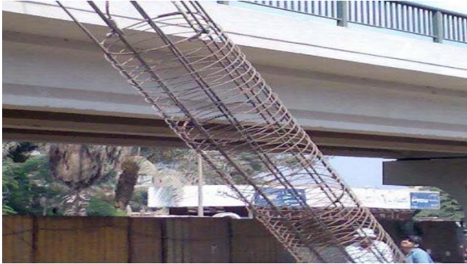
12 – تسليخ الخازوق بعد الانتهاء منه , ويلاحظ ان يترك الجزء العلوي دون كانات حيث سيتم التكسير به
