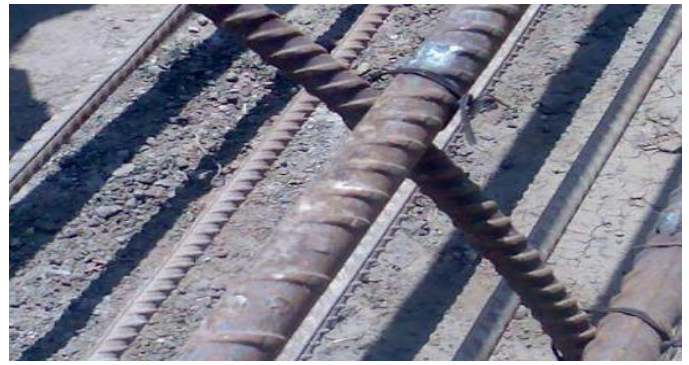
11 – تجهيز الكانات الحلزونية سبيرال – Spiral – ليتم لفها حول الاسياخ الرأسية للخازوق , تكون من حديد 8مم
