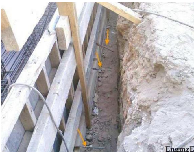
12-تدعيم الجانب الخارجي من الشده بشكل مبدئي حتى استكمال اعمال الحداده وتدعيمه بشكل نهائي بالزجينه من الطرفين
