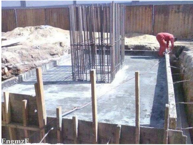
28-شكل القاعده بعد الانتهاء من الصب
