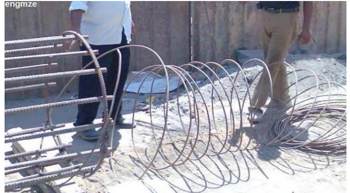
11 – تجهيز الكانات الحلزونية سبيرال – Spiral – ليتم لفها حول الاسياخ الرأسية للخازوق , تكون من حديد 8مم
