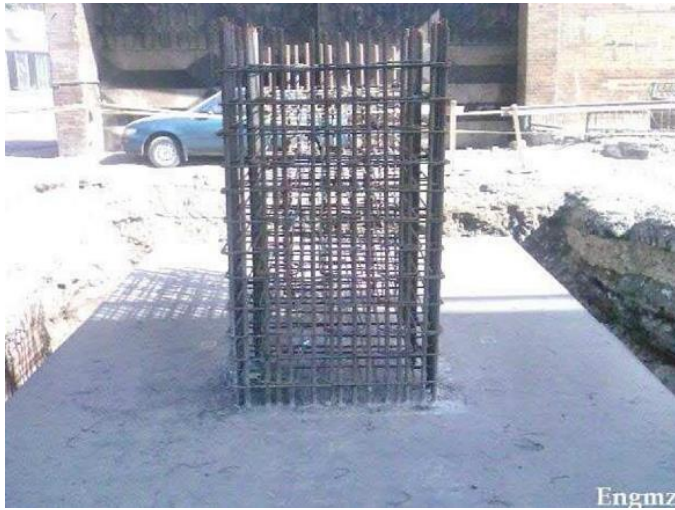
28-شكل القاعده بعد الانتهاء من الصب
