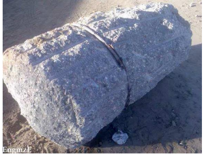
7-تكسير الكتل الخرسانية ورفعها بواسطة الونش
