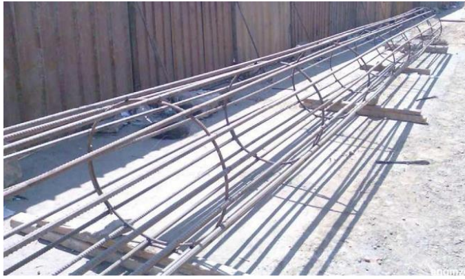
12 – تسليخ الخازوق بعد الانتهاء منه , ويلاحظ ان يترك الجزء العلوي دون كانات حيث سيتم التكسير به
