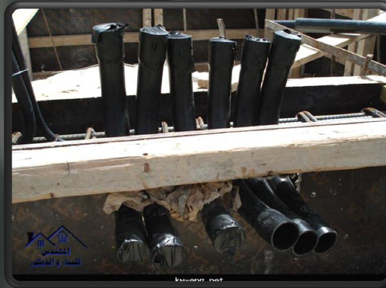
**- ثانياً:** تركيب شبكة الأنابيب البلاستيكية المفرغة وسحب الأسلاك وتستخدم شبكة الأنابيب البلاستيكية المفرغة في ربط الأعمال الكهربائية بعضها ببعض.
