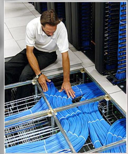
في المشروعات الصناعية يفضل استخدام cable trays لان الكابلات تكون مكشوفة وبتسريب الحرارة يكون افضل, كما يسهل تتبع الاخطاء. وبالتالي
