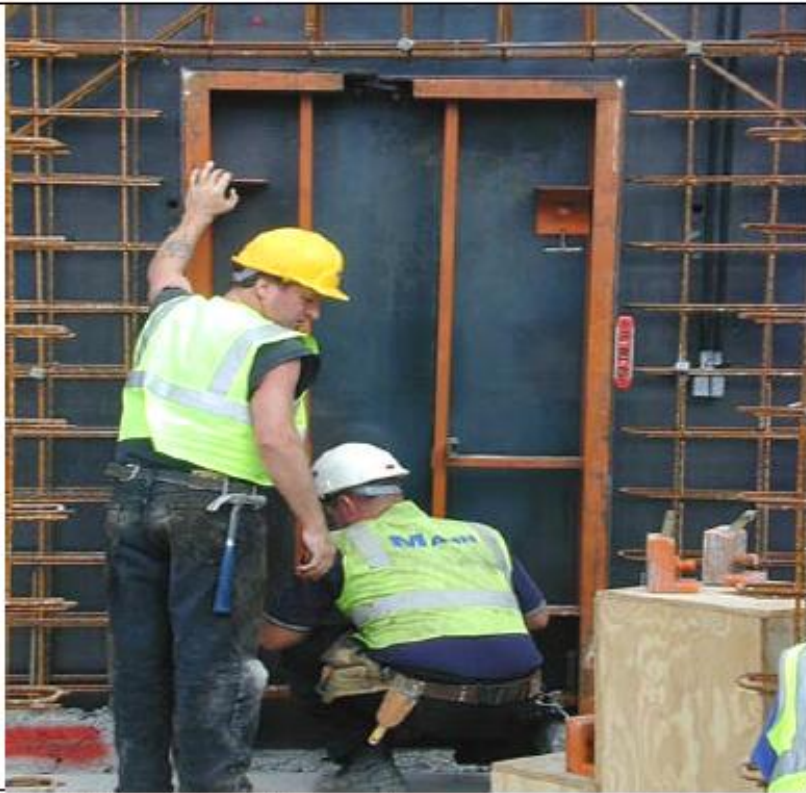
Installing door boxout
