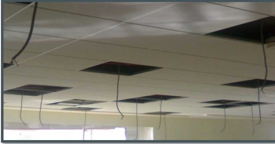
هذه سلوك الكهرباء التي توضع بها الاضاءة
