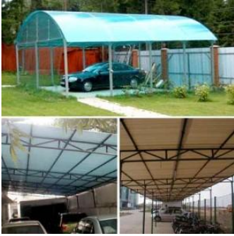
تغطية الفراغات المفتوحة بال fiberglass
