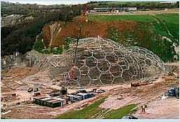
صورة توضح تركيب النظام الانشائي الحامل للسقف
