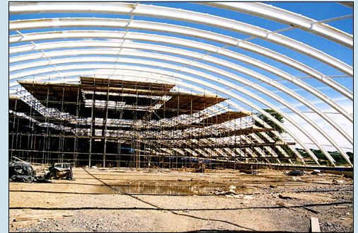
صورة توضح تركيب النظام الانشائي الحامل للسقف
