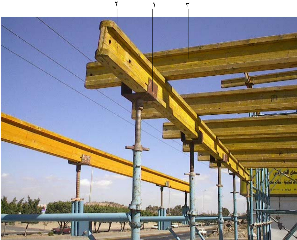
شكل رقم (٨٨) يبين حوامل المدادات (اليوهيد) ١ - حوامل المدادات (اليوهيد) ٢ - العرقات ٣ - التطاريج
