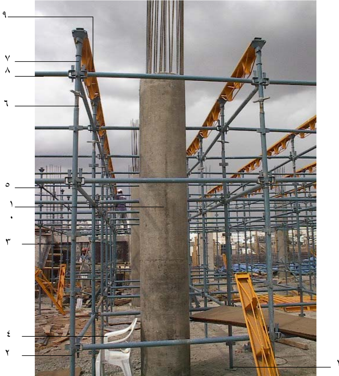
شكل رقم (١٠٢) مكونات تركيب الشدة المعدنية
