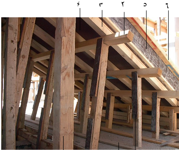
شكل رقم (٥٦) تخشيب القلبة السفلية للسلم
