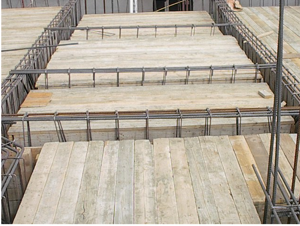
شكل رقم (٧٣) يبين بدء تركيب أعمال الحدادة للكمرات
