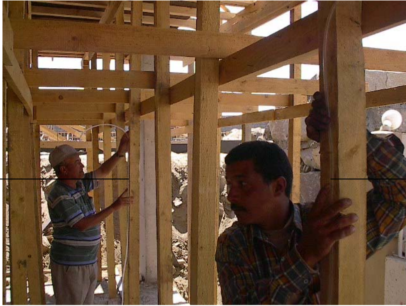
شكل رقم ( ٣٥ ) يبين نقل الشرب باستخدام ميزان المياه
