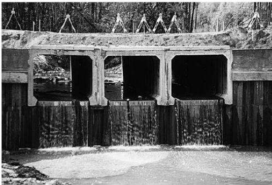
الشكل (٦): عبارة صندوقية من الخرسانة مسبقة الصنع
