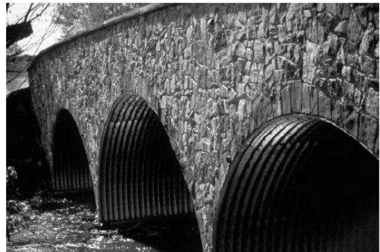
الشكل (٥): عبارة من الحديد المموج
