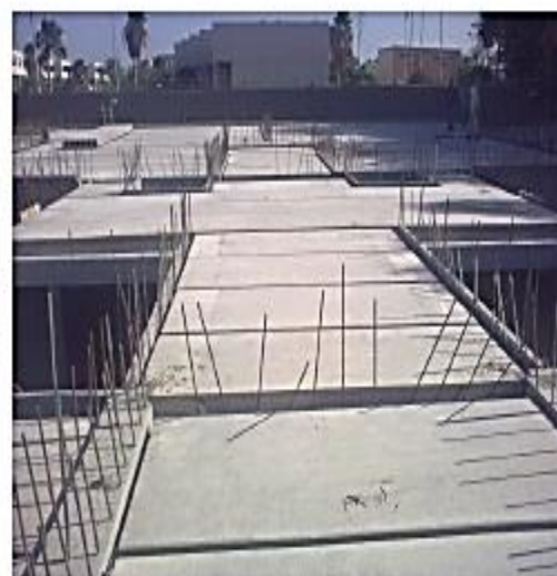
الهولي كور اسلاب بعد الانتهاء من تركيبه وضبطه جيدا وهيا فكرته تقوم علي فكرة SIMPLE BEAMS
