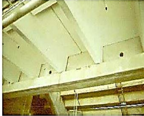
سقف من البلاطات شكل II والكمرات سابقة الصب
