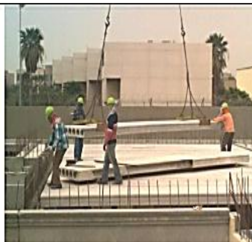
نقل وتركيب الهولي كور اسلاب بواسطة الفنين في امكانها المحدثه في المخطط
