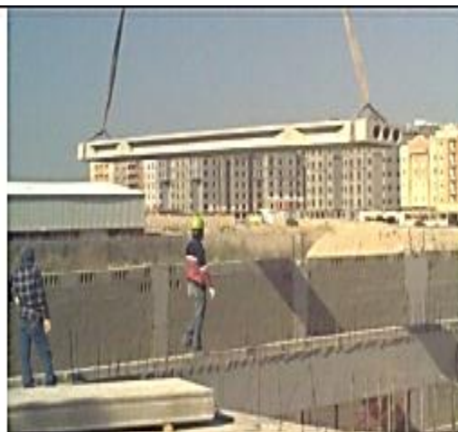
نقل وتركيب الهولي كور اسلاب بواسطة الفنين في امكانها المحدثه في المخطط
