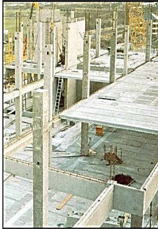
صورة موقع عام وتظهر به الأعمدة وباقي العناصر الإنشائية من الخرسانة سابقة الصب.
