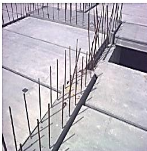
الهولي كور اسلاب بعد الانتهاء من تركيبه وضبطه جيدا وهيا فكرته تقوم علي فكرة SIMPLE BEAMS
