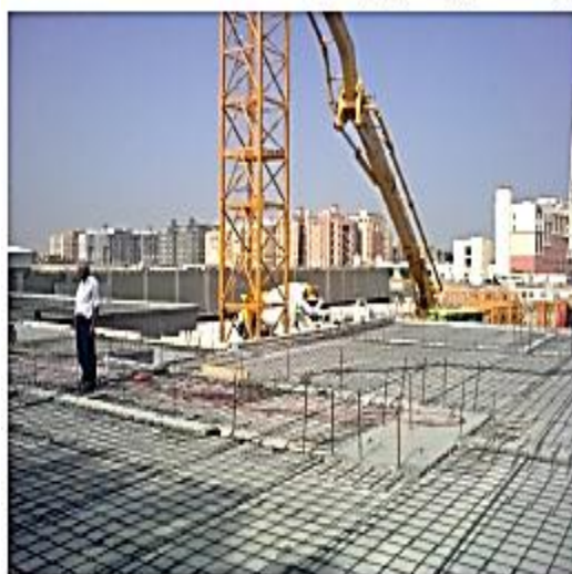
ومن ثم عمل الشبكة المسلحة استعدادا لصيها بعد ذلك لتربط كافة الاجزاء المركبة ببعضها
