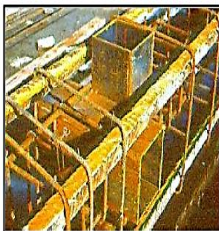
تجهيز الجزء المعدني البارز Steel insert داخل القفص الحديدي للعمود قبل صبه.
