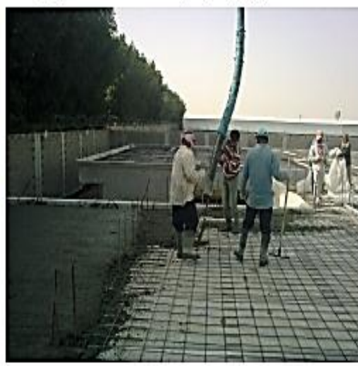
ومن ثم عمل الشبكة المسلحة استعدادا لصيها بعد ذلك لتربط كافة الاجزاء المركبة ببعضها
