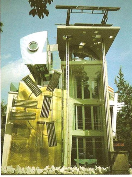
مبنى سكن ومكتب في مدينة هامبورج بالمانيا للمعماري ستوتر حيث يظهر بالواجهة مجمعات شمسية جافة لتخزين الطاقة الشمسية وتسخين المياه من خلالها.
