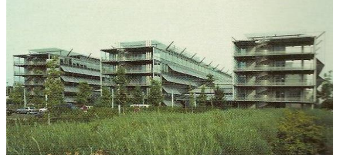
استخدام المظلات الشمسية كهيكل حامل للخلايا الفوتوفلاطية
