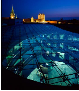
تثبيت الاسقف الزجاجية بالنظام المفصلى
