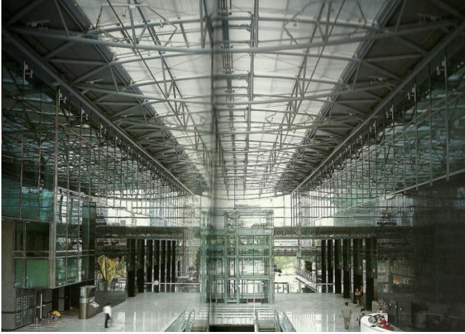
لقطة توضح الزجاج الخارجي وطريقة تثبيته وهي التثبيت العنكبوتي
