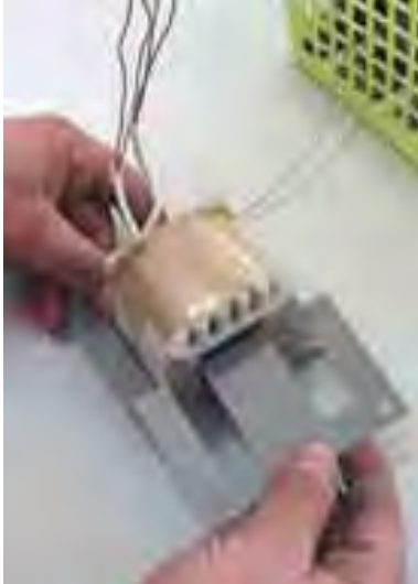
الشكل (٢-٢): فك براغي تثبيت هيكل المحول وسحب الصفائح الشكل (٢-٣): وضع شرائح المحول في مكان مناسب لحين التجميع الشكل (٢-٤): إعادة تركيب صفائح الحديد
