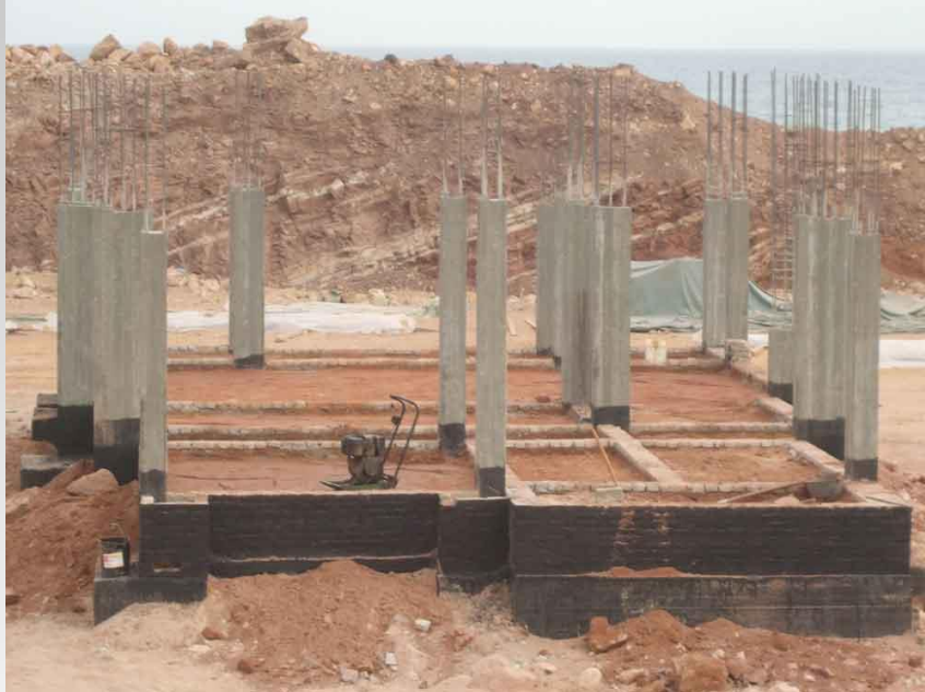
رش الرمل بالماء وكدة جيدا (ملحوظة في هذا الموقع لم نكن بحاجة لعمل طبقة تحت مباني قصة ردم)
