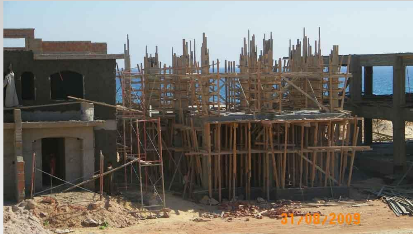
عمل شدات اعمدة الدور الاول و يوضع حديد تسليح الأعمدة مع ملاحظة ترك طول لأشابير للسطح تصب الأعمدة حتى منسوب بطينة كمرات الدور الاول
