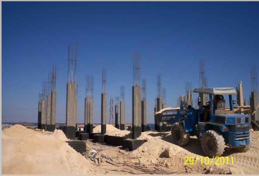
دهان الخرسانة المسلحة للأثاث بالبثومين ثم الردم حول القواعد
