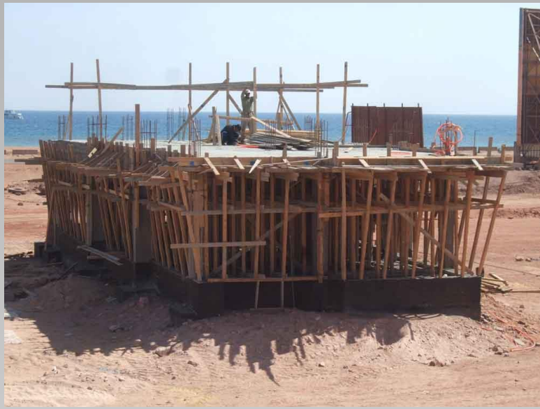
يصب سقف الدور الأرضي ويفك شدة السقف بعد أتمام المدة المحددة لها التي لا تقل عن أسبوعين
