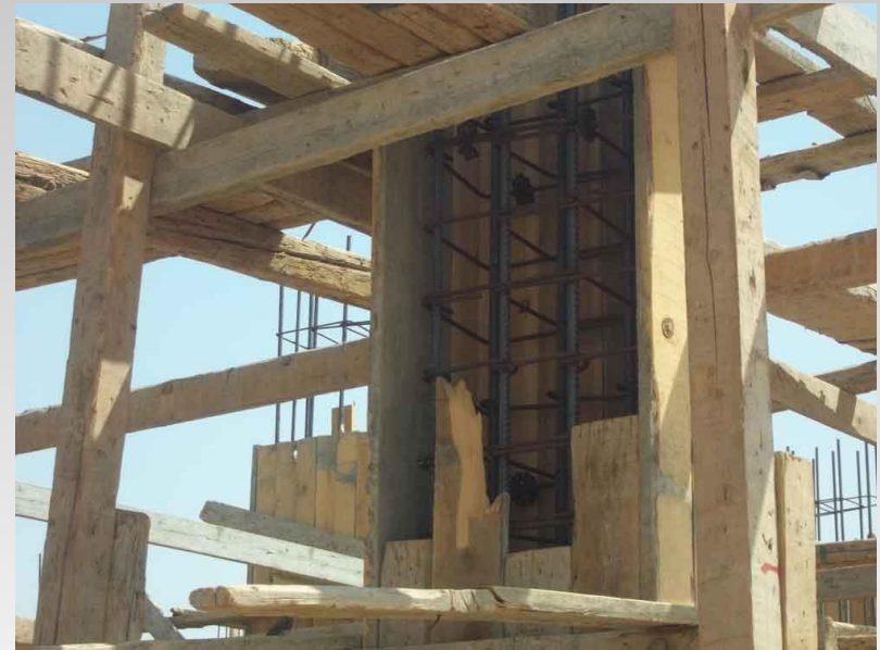
وضع البسكوت على الحديد لترك سمك (رقعة) 2.5 اثناء الصب
