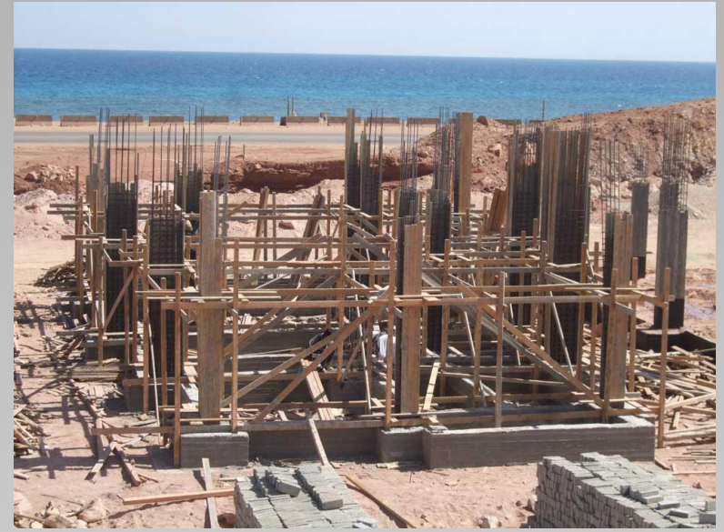
عمل الجوانب الخشبية لرقاب الأعمدة حتى منسوب قاع الميدة وأعداد تسليحها ثم صبها
