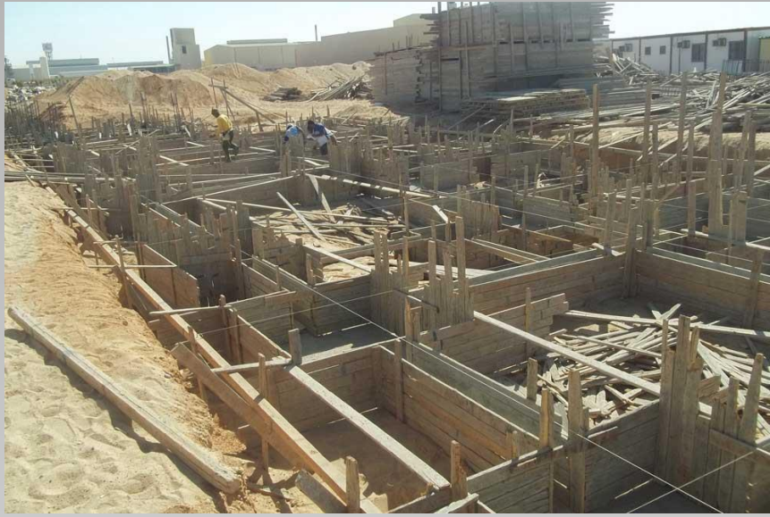
عمل جوانب القواعد الخرسانية المسلحة تبعاً لأبعادها بالرسومات الإنشائية
