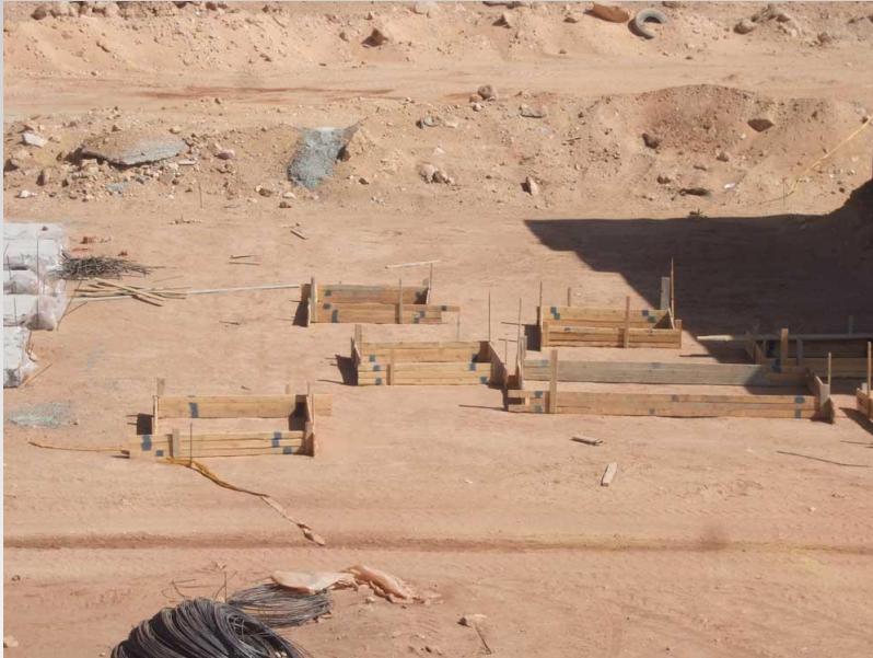
عمل جوانب القواعد العادية تبعا لأبعادها بالرسومات الإنشائية
