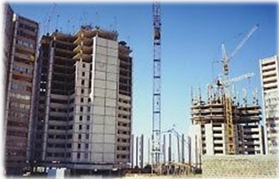
صورة (3-15) توضح مبنى يتم أكساء الأدوار السفلى منه في حين يتم إكمال البناء في الأدوار العليا (دراسات سابقة - رأفت الجوبجي وآخرون - 2011/2010)
