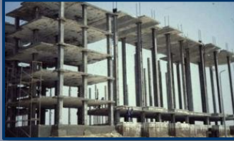
شكل المبنى بعد الإنتهاء من رفع جميع البلاطات في الجزء الأسفل
