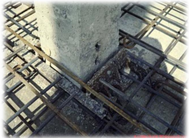
صورة (3-5) توضح تثبيت العمود داخل الأساسات http://www.mediafire.com/?9238bej1eg8g19w
