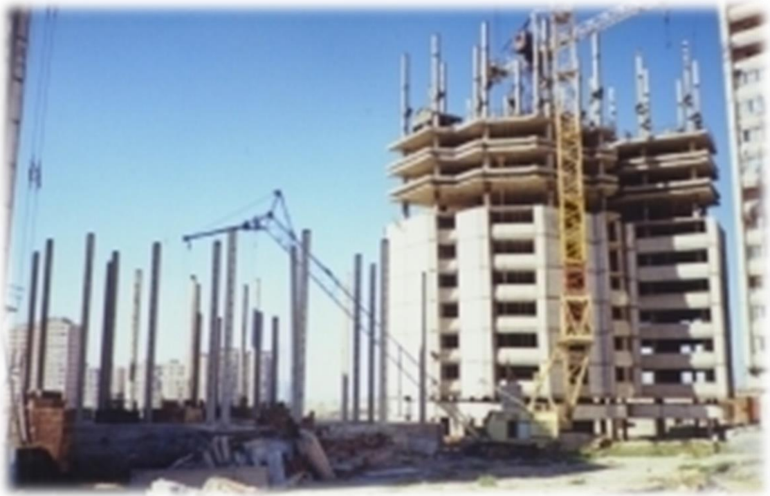
صورة (3-7) توضح إنشاء مبنى بنظام البلاطات المرفوعة http://www.mediafire.com/?9238bej1eg8g19w
