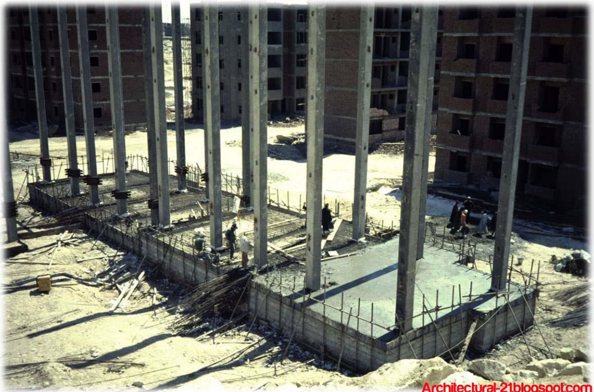
صورة (17-3) توضح صب البلاطات في مستوى الدور الأرضي ( http://www.mediafire.com/?9238bej1eg8g19w )
