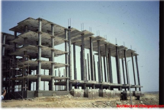
صورة (2-3) توضح البلاطات المرفوعة http://www.mediafire.com/?9238bej1eg8g19w
