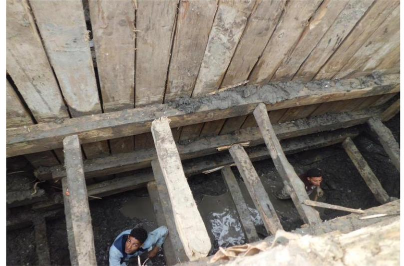
■ ثم يتم بعد ذلك التدعيم بعروق خشب عرضيه أخرى عموديه على الأخشاب العرضيه و توضع هذه الأخشاب متوازيه فى نفس المنسوب و على أبعاد متساويه و توضع كذلك على مناسيب مختلفه حتى نهايه الحفر و يتم سحب المياه الجوفيه الموجوده بالقاع و ذلك للتهيئه لوضع الماسوره وذلك عن طريق ظلمبه سحب تقوم بسحب المياه الجوفيه الموجوده فى الحفره .
