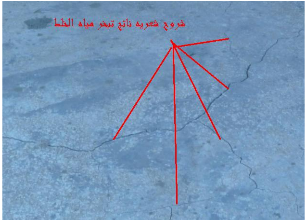
صورة الشروخ الشعريه ناتج تبخر مياه الخلط
