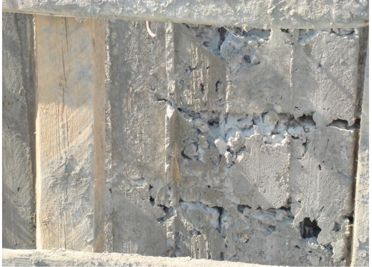
صورة التعشيش (تسويس) بالخرسانه
