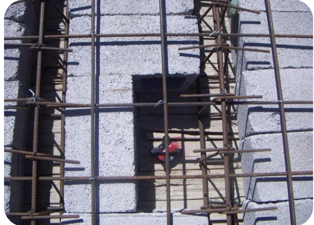
صوره (١٨٤-٢) توضح فصمة الطوب لعلبة الكهرباء - بحث عام ٢٠١٢-٢٠١٣ م
