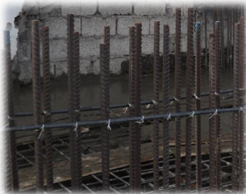
الصورة (٩٠-٢) توضح تثبيت إشارات الرقاب بواسطة كانه وذلك للحفاظ على المسافة بين أسياخ الحديد-الباحث ٢٠١٢-٢٠١٣ م
