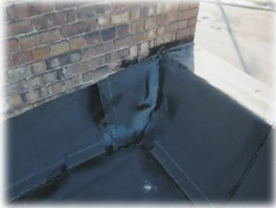
صورة (٢-١٩٣) (توضح تنفيذ العازل عند حواف الأسطح) (بحث عام ٢٠١٢-٢٠١٣) ( www.4shaed.com )
