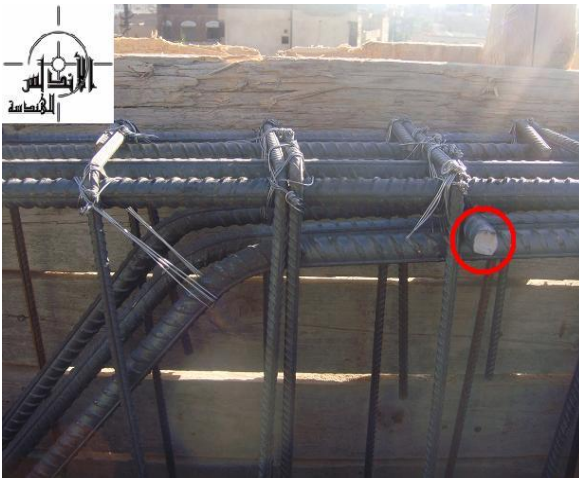
الصورة (٥٧-٢) توضح طريقة تركيب الثخانات (الإنترنت)
