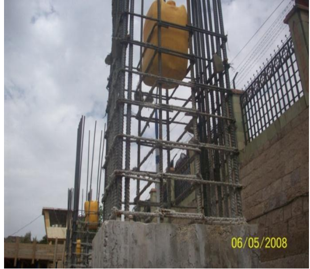
صورة (١٣٢-٢) توضح الرش باستخدام الأواني (دراسة سابقة - رأفت الجوبحي وآخرون - ٢٠١٠/٢٠١١م)
