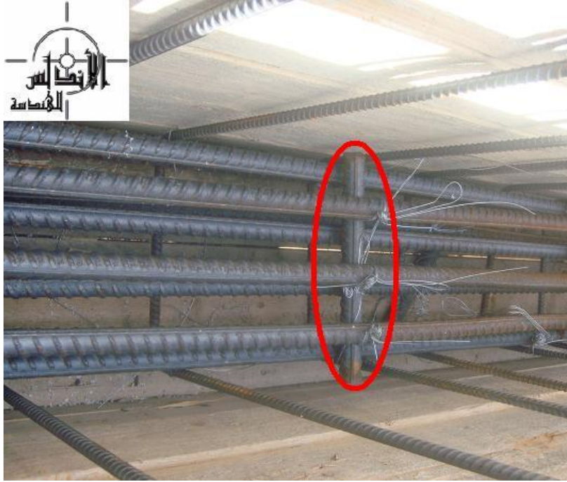
الصورة (٥٨-٢) توضح طريقة تركيب الثخانات (الإنترنت)
