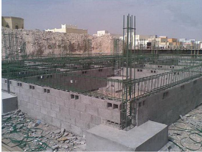
الصورة (٧٠-٢) توضح الكرسي مع القواعد وحديد تسليح الميـد (www.kutub.com ٢٠١٣ - ٢٠١٤م
