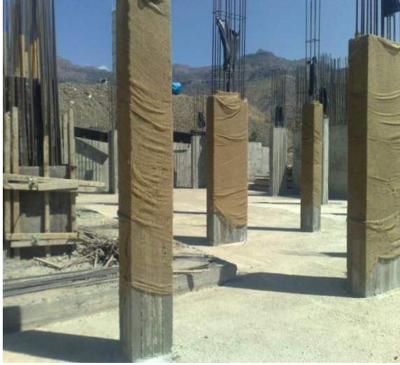
صورة (١٣٣-٢) توضح الرش باستخدام الخيش أو الأنسجة القطنية (دراسة سابقة - رأفت الجوبحي وآخرون - ٢٠١٠/٢٠١١م)
