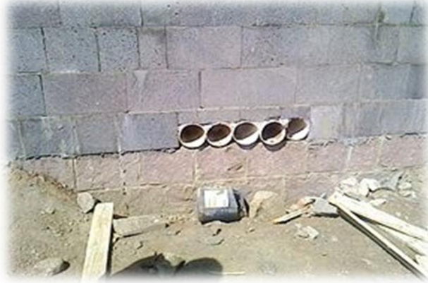
الصورة (٩٦-٢) توضح تنفيذ فتحات الكهرباء في المبددة-
