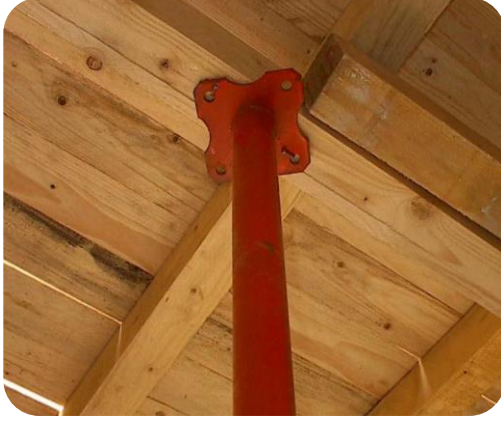
صورة (١٥٨-٢) توضح الرأس العلوية للماسورة الداخلية
