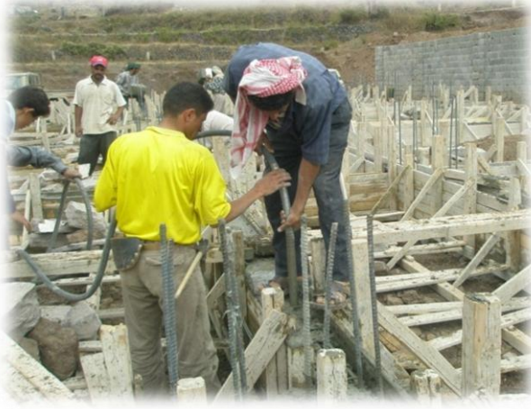
الصورة (١٠٠-٢) توضح استخدام الهزاز عند صب الميد-الباحث ٢٠١٢-٢٠١٣م
