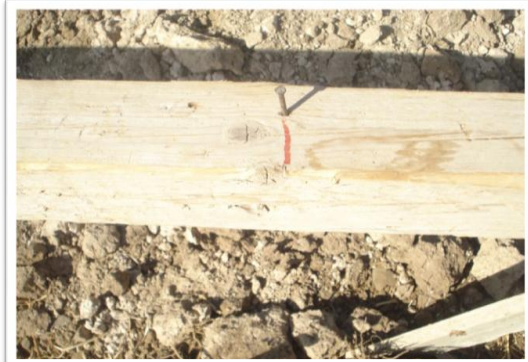
الصورة (١٦-٢) توضح وضع أرقام المحاور على المدادات (دراسة سابقة - عمر الزهيري وآخرون - ٢٠١٠/٢٠١١م)
