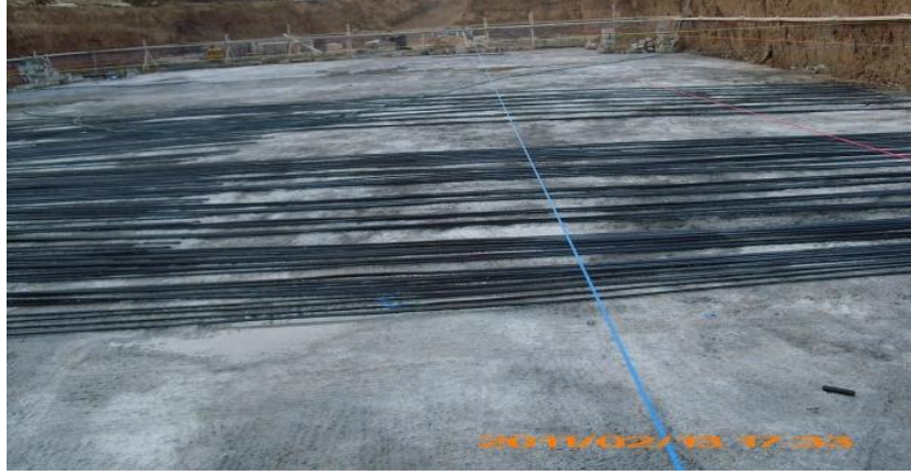
الصورة (٥٢-٢) توضح طبقة النظافة " الخرسانة العادية ( الباحث )
