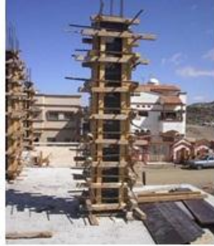
صورة (٢-١٢٩) توضح التكتيف للجوانب الأربعة حسب الرسومات (دراسة - رأفت الجوبحي وآخرون- ٢٠١١/٢٠١٢م)
