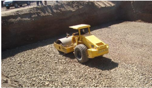
الصورة (٢-٥١) توضح عملية دك التربة والجعم (الباحث- سكن الندوة - إب ٢٠١١ - ٢٠١٢ م)
