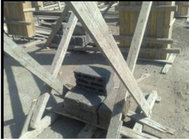
صورة (١٢٤-٢) توضح الثقافات و الوشاح بزاوية ٤٥ درجة (الجويحي وأخرون ٢٠١١-٢٠١٢)
