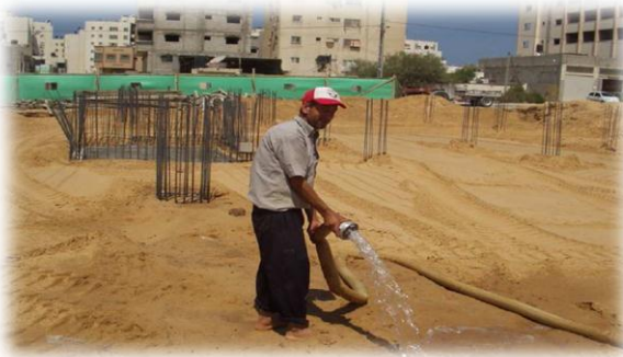
الصورة (١٠٥-٢) توضح أعمال الرش لتربة الدفن www.kutub.com ٢٠١٢-٢٠١٣م
