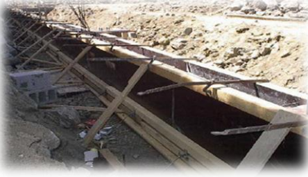
الصورة (٨٧-٢) توضح التقوية باستخدام المربيع والقمط والزراجين www.kutub.com ٢٠١٢-٢٠١٣ م
