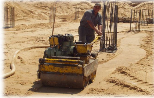
الصورة (١٠٦-٢) توضح أعمال الدك باستخدام الدكاكة www.kutub.com- اليدوية ٢٠١٢-٢٠١٣م
