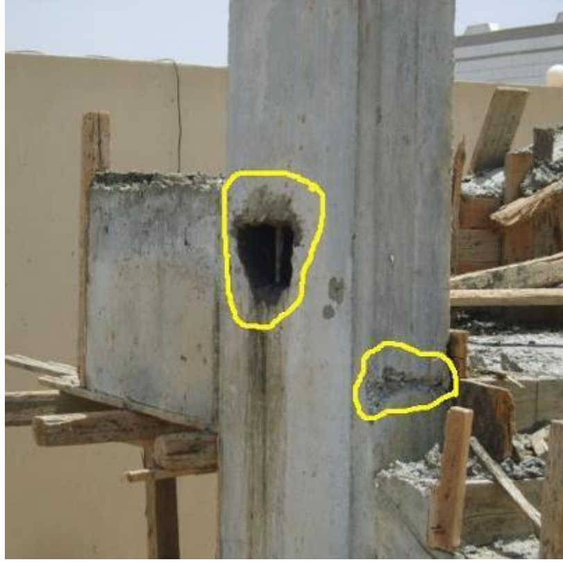
صورة (١٣٨-٢) توضح وقوع فقاعات هوائية داخل العمود بسبب عدم استخدام الهزازات مما يحدث أضرار وضعف في العمود الخرساني (فيس بوك شبكة المعرفة الهندسية)
