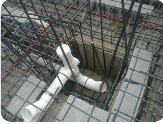
صورة (٢-١٧٩) توضح غرفة التفتيش على السطح حيث تجمع المواسير الهيا ثم تمر الماسورة الى النفق الأفقي، (الباحث ٢٠١٣/٢٠١٤م)
