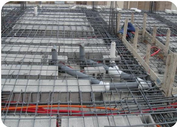
صورة (١٨٧-٢) توضح التمديدات الكهربائية والصحية على السقف (أرشيف الباحث-٢٠١٣/٢٠١٤ م)
