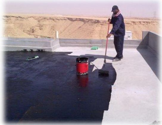
صورة (٢-١٩٢) (توضح تنفيذ العازل للأسطح) ( www.4shaed.com ) (بحث عام ٢٠١٢-٢٠١٣)
