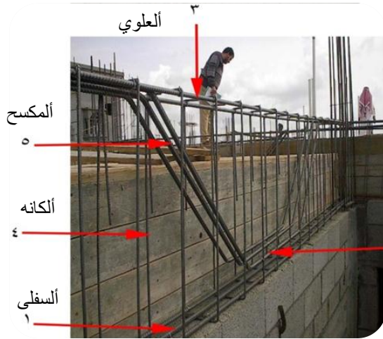
صورة (١٦٩-٢) توضح تسليح الكمرات في البلاطات العادية (مرجع الصورة السابقة)
