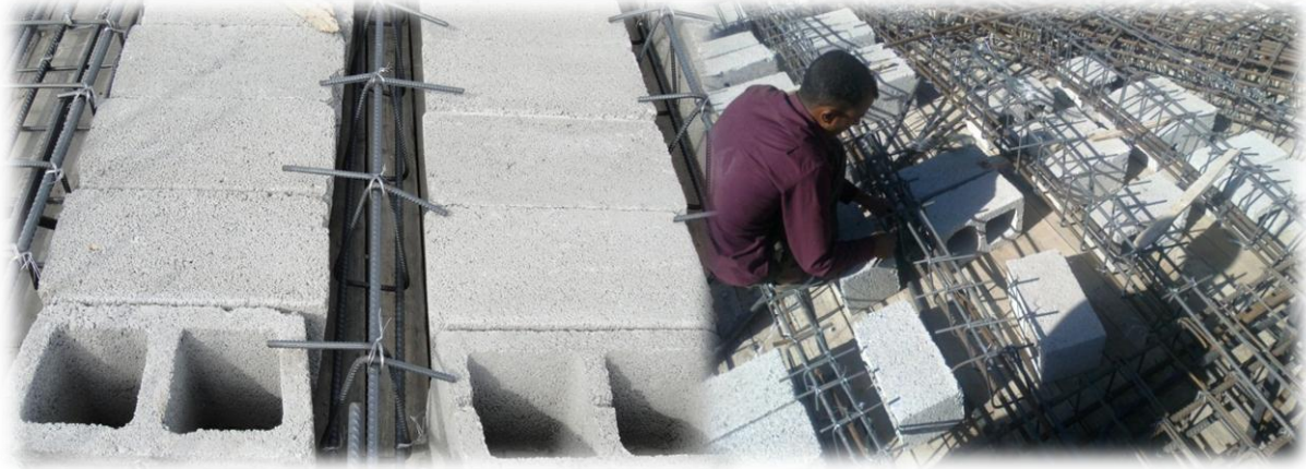
صورة (٢-١٧٢) توضح الكانات المربعة في الأعصاب (الباحث-تنفيذ جامع الوقيان-قحز-إب - ٢٠١٣/٢٠١٤ م)
