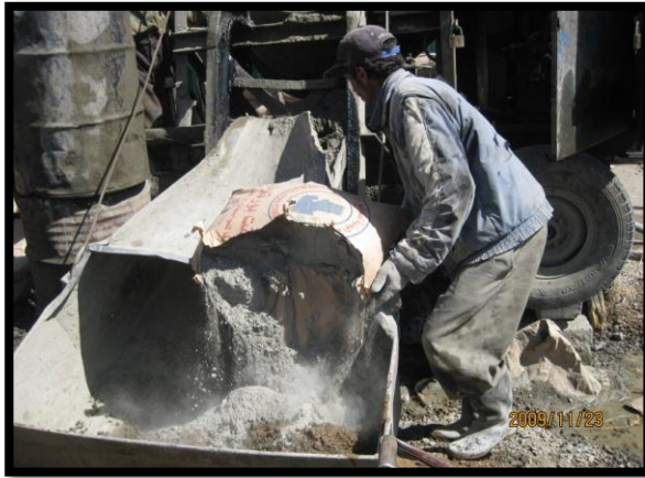
الصورة (٦٣-٢) توضح ضبط نسب الخلط - (دراسة سابقة ٢٠١٠ - ٢٠١١ م)
