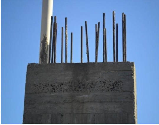
صورة (٢-١٣٥) توضح الإشارة غير كافية لا تزيد عن ٤٠ سم منها ٣٠ سمك بلاطة السقف أيضاً وضع الماسورة داخل العمود.(رافت الجوبجي واخرون-
