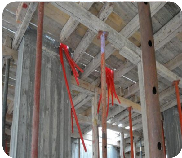
صوره (١٨٦-٢) توضح مواسير الكهرباء - بحث عام ٢٠١٢-٢٠١٣ م
