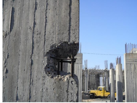
صورة (٢-١٣٤) توضح كسر العمود الأمر الذي يؤثر على الحسبة الإنشائية للعمود(رافت الجوبجي واخرون-٢٠١٠/٢٠١١م)
