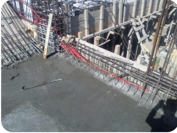
صورة (١٨٥-٢) توضح تمديدات بيبات الكهرباء داخل الجسور (الباحث-تنفيذ جامع الوقيان -قحزہ- إب- ٢٠١٣/٢٠١٤ م)
