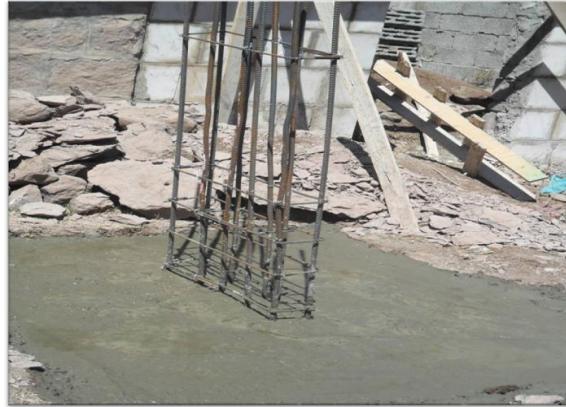
الصورة (٦٨-٢) توضح تساقط التربة على الخرسانة ( دراسة سابقة ٢٠١٠ - ٢٠١١ م )
