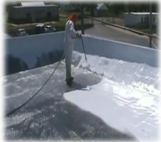
صورة (٢-١٩٤) (توضح تنفيذ عازل البولي يوريثين على الأسطح) (بحث عام ٢٠١٢-٢٠١٣) ( www.4shaed.com )
