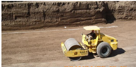
الصورة (٢-٥٠) توضح عملية دك التربة (الباحث- سكن الندوة - إب ٢٠١١ - ٢٠١٢ م)
