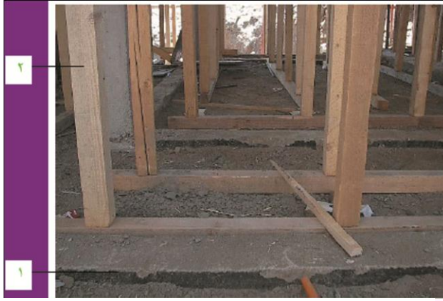
شكل (٢-١١٦) يوضح استخدام الفرشات أسفل القوائم الرأسية (مجموعة التنسيق- الجبري وآخرون ٢٠١٣-٢٠١٤م) ١- الفرشات ٢- القوائم الرأسية
