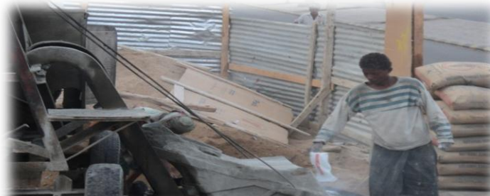
الصورة (٩٩-٢) توضح إضافة مادة السيكا للخلطة الخرسانية لمقاومة الأملاح-الباحث ٢٠١٢-٢٠١٣م
