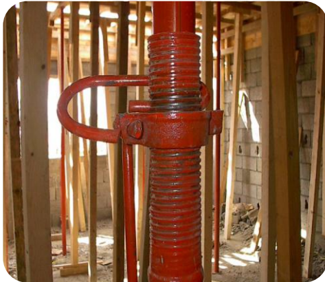
صورة (١٦٠-٢) توضح الجزء الأوسط للقائم ( وصلة الضبط )
