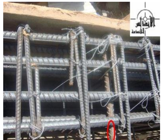
الصورة (٥٦-٢) توضح طريقة تركيب الثخانات (الإنترنت)
