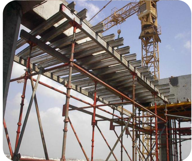
صورة (١٦٦-٢) توضح العرقات و التطاريح (المؤسسة العامة للتعليم الفني والتدريب المهني "ورش شدات ووحدات تسليح باب الشدات المعدنية، المملكة العربية السعودية)
