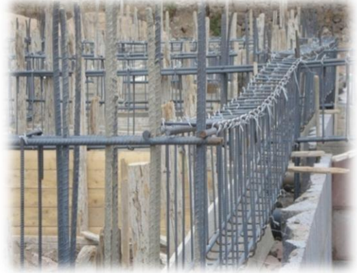
الصورة (٨٩-٢) توضح تركيب أسياخ التسليح فوق الشدة الخشبية -دراسة سابقة - رأفت وآخرون - ٢٠١٢-٢٠١٣ م
