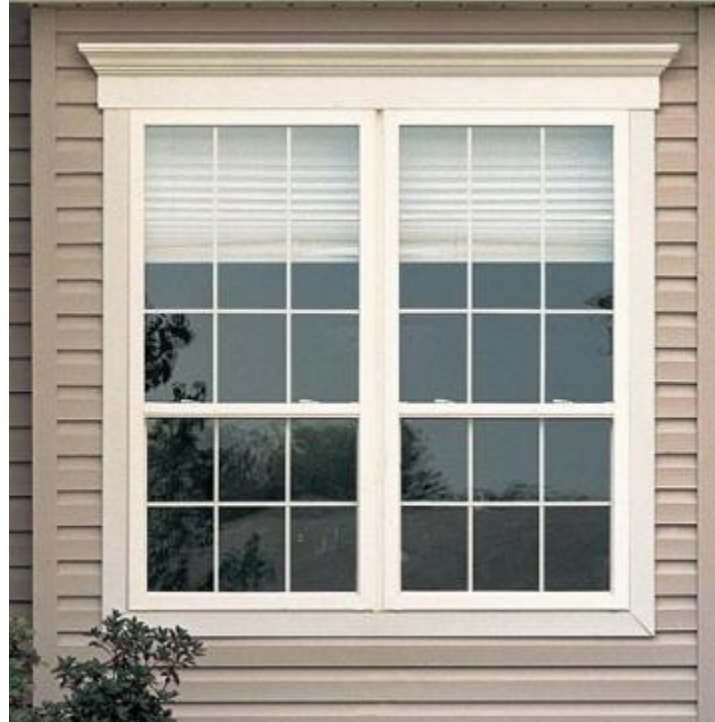
● و كل باب أو شباك مكون من شقين ● شق مثبت في الحائط يسمى الإطار ( الحلق ) .
