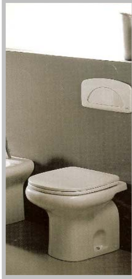
شكل رقم (12) - استخدام صمام الطرد بدلاً من صندوق الطرد في صرف المراحيض
