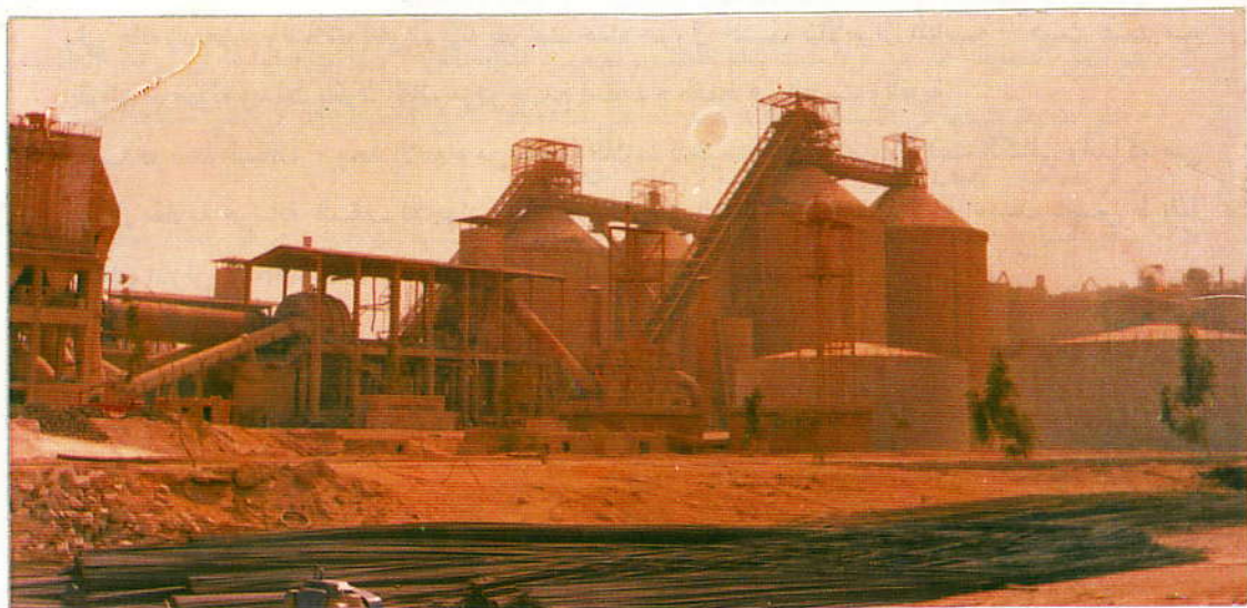
صورة توضح صوامع مصنع الاسمنت القوميه حيث تم تنفيذ الحوائط بأسلوب الشدات المنزلقه والسقف باستخدام أسلوب ( Lift Slab )
