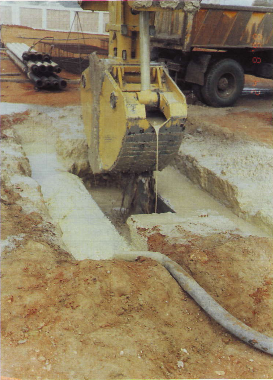
صورة فوتوغرافية توضح الحفار أثناء الحفر للحوائط اللوحية
