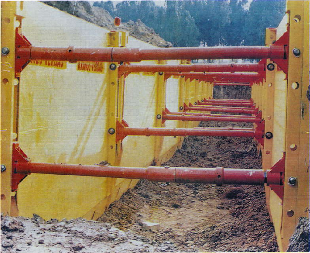
شكل ( ٥ ) صورة فوتوغرافية توضح التركيب الداخلي للحفر
