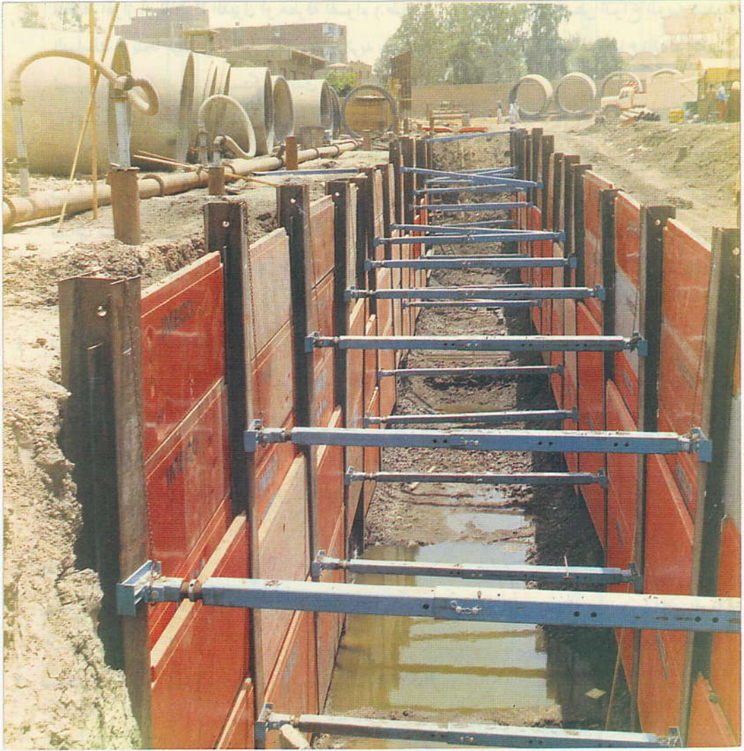
صورة فوتوغرافية توضح الشدات المعدنية للمجمعات الكبرى عمق يصل إلى ١٠ متر
