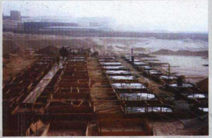
• تنظيم طريقة الصب للخرسانة العادية
