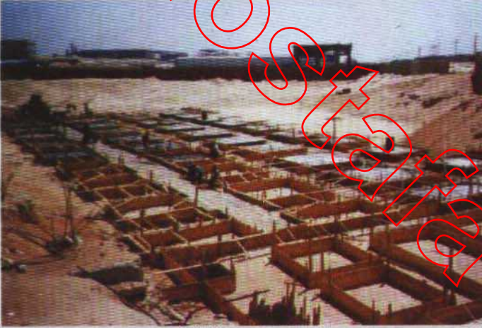
• تنظيم طريقة الصب للخرسانة العادية
