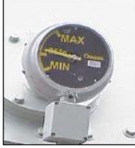
شكل 1-15 : مؤشر الـ Liquid Level
