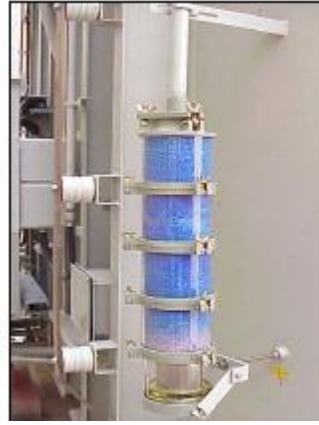
شكل 15-2 : شكل الـ Breather
