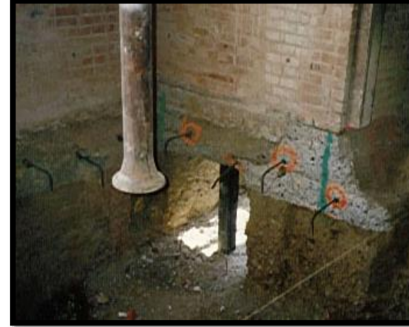
إستخدام الطوب المصمت أسفل الطبقة العازلة
