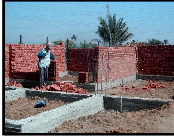
إستخدام الطوب الأحمر أعلى الطبقة العازلة
