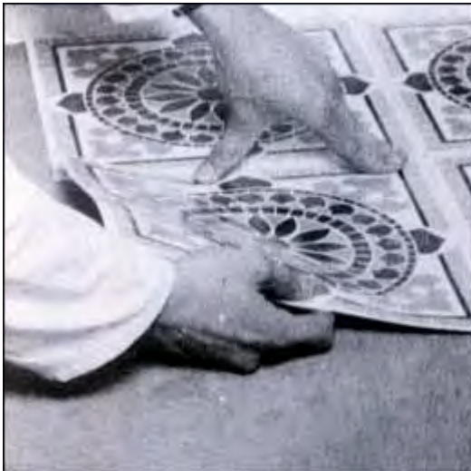
تنشيت بلاط الفينيل على طبقة النايتوفلور ليفل توب التحتية.
