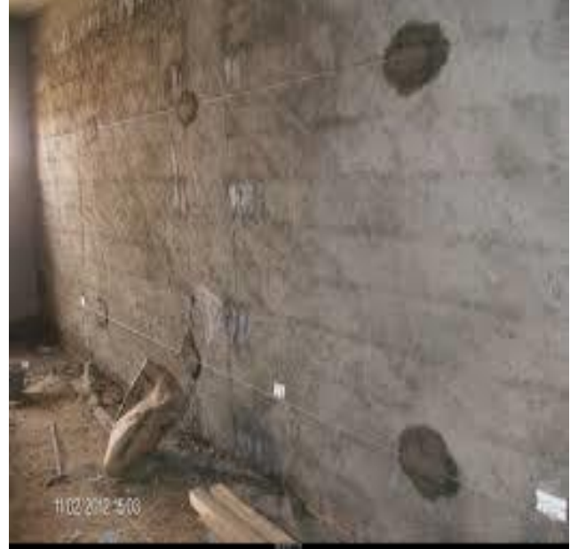
وجود حرامية كثيرة في الطرشة ظهور شروخ لعدم وضع شبك علي الخرطوم
