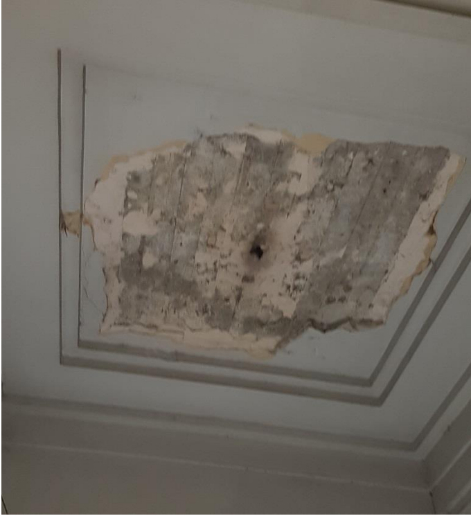
تنفيذ الطرشة مسيله والوتر بطريقة سيئة سقوط بياض السقف لزيادة سمكه عن ١,٥ سم
