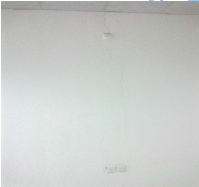
وجود حرامية كثيرة في الطرشة ظهور شروخ لعدم وضع شبك علي الخرطوم
