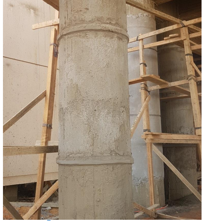
تنفيذ الطرشة مسيله والوتر بطريقة سيئة سقوط بياض السقف لزيادة سمكه عن ١,٥ سم
