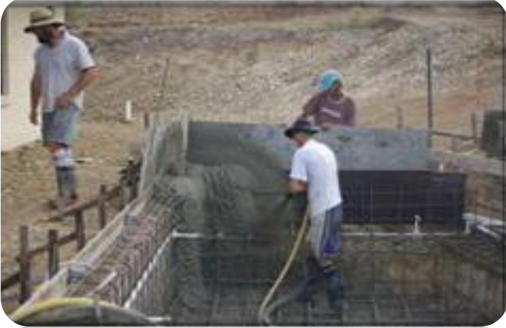
صورة اثناء صب الخرسانه
