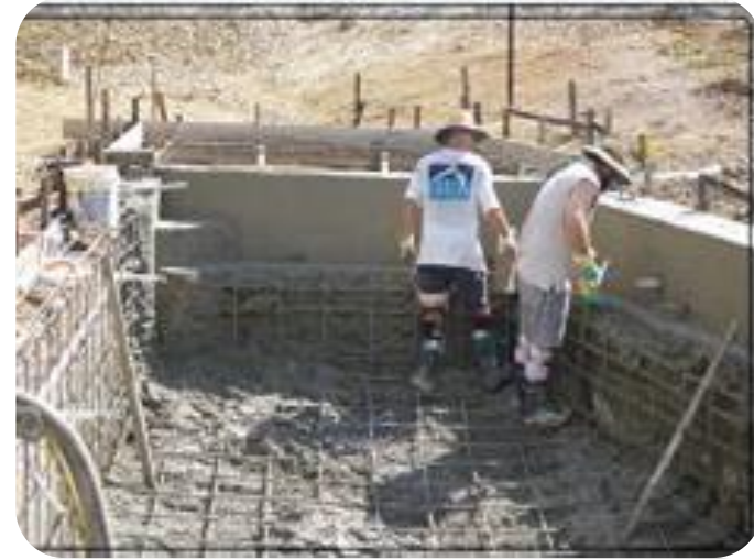
صورة اثناء عمل الحوائط الجانبية
