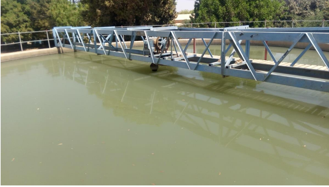
ملحق (7) حوض مزج بطيء للمحطة القديمة
