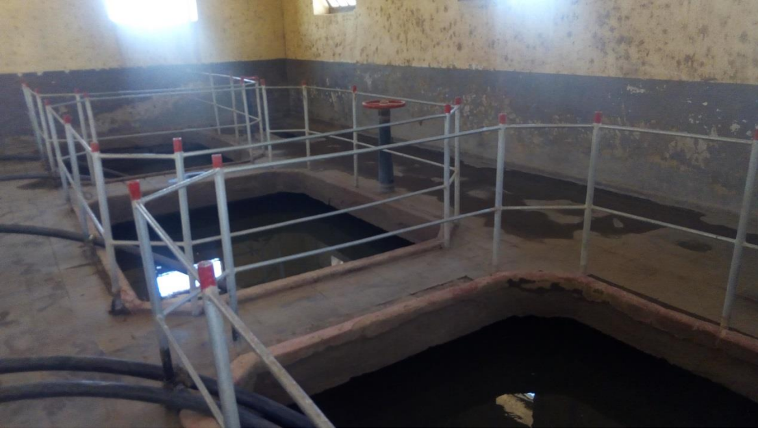
ملحق(5) المرشحات الرملية للمحطة القديمة
