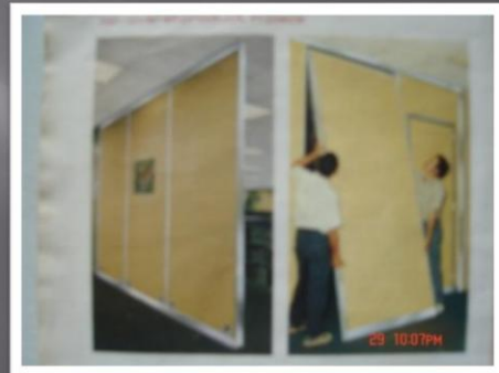
القواطع القابلة للفك و التركيب وكيفية تنصيبها في السقف و الأرض
