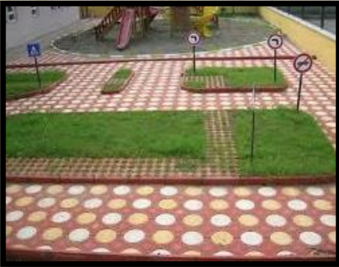
استخدام أرضيات إنترلوك في الهاردسكيب
