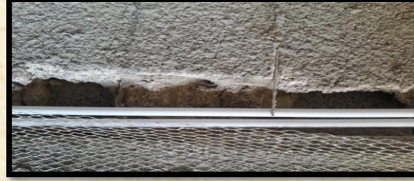
استخدام السلك لتغطية أسلاك الكهرباء
