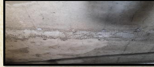
استخدام السلك لتغطية أسلاك الكهرباء
