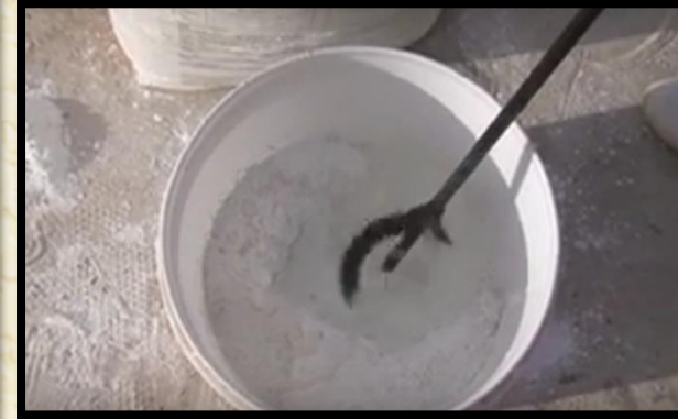
خلط الاسمنت بالماء
