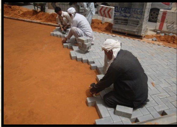
3- يتم تركيب ارضيات الانترلوك
