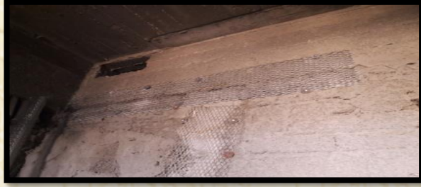
استخدام السلك للفصل بين انواع الماتريال المختلفه
