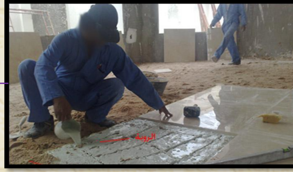
فرد المونه الاسمنتيه اسفل البلاطه بالكامل
