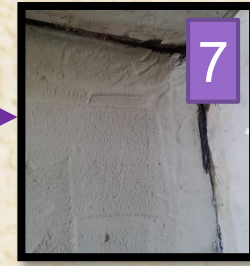
7- عمل السباكه اللازمه ووضع طبقة من الرمل ثم المونة بسمك 2سم
