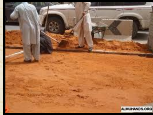
2- يتم غمر الرمال بالمياه وتسويتها
