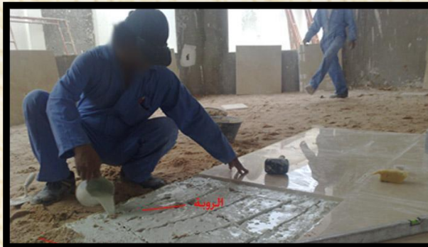
فرد المونة الاسمنتية اسفل البلاطة بالكامل وتركيب ارضيات الرخام
