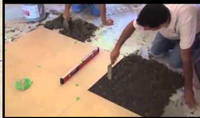
فرد المونه الاسمنتيه اسفل البلاطه بالكامل
