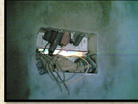
تركيب العلب الكهربائية
