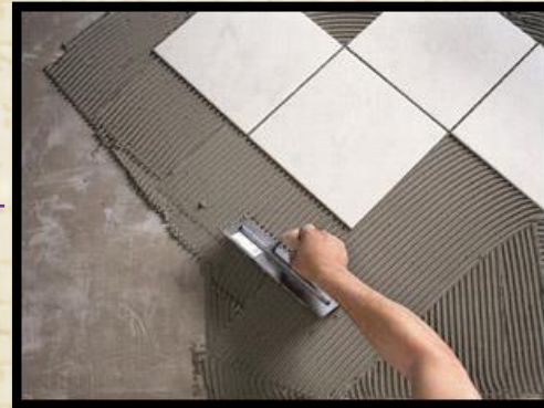
فرد المونه الاسمنتيه اسفل البلاطه بالكامل
