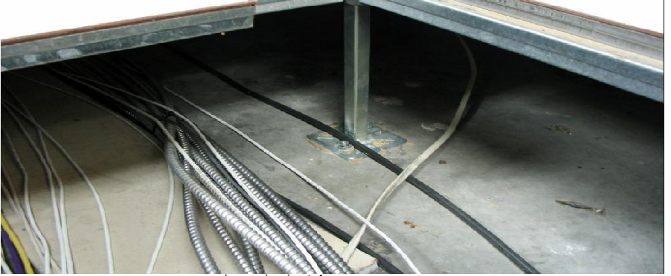
صوره توضح مجموعه من الكابلات و فوقها أحد أنواع الأرضيات المرتفعة
