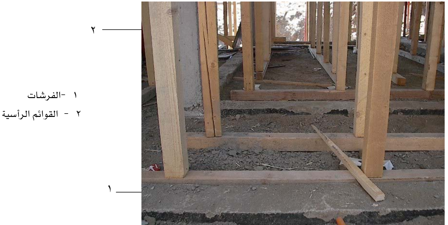
شكل رقم ( ٢٤ ) يبين استخدام العروق الفليري كفرشات أسفل القوائم الرأسية بالدور الأرضي
