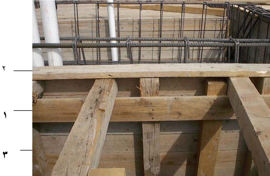
شكل رقم ( ٣٦ ) يبين لوح الزنق في جنب الكمرة
