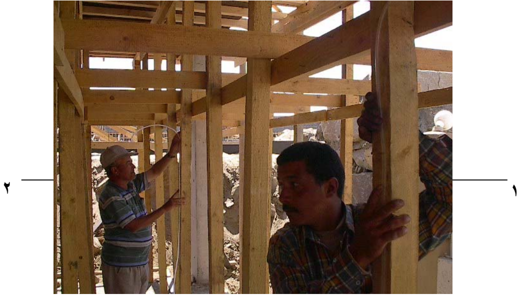
شكل رقم ( ٣٥ ) يبين نقل الشرب باستخدام ميزان المياه
