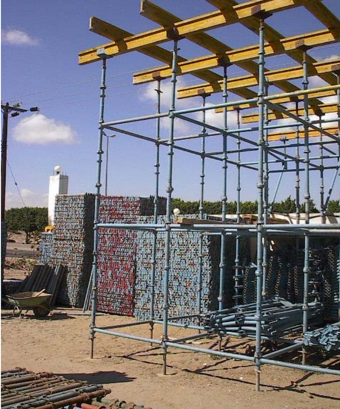
شكل رقم (٨٠) أعمال الشدة المعدنية بنظام الكابلوك
