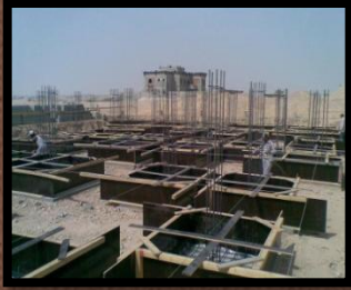
الهيكل الخشبية للقواعد التي تصمم طبقاً لمقاس القواعد الخرسانية
