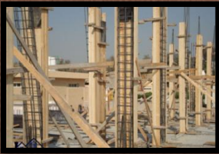
الشدّة الخشبية للأعمدة التي سيتم صب الخرسانة بها
