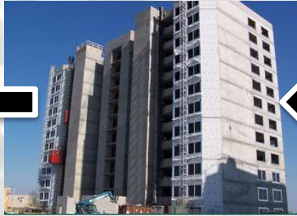
بعد الإنتهاء من صب الخرسانة لجميع الأدوار تكون الأسطح ملساء جدا لا تحتاج إلا معالجة بسيطة للتشطيب.
