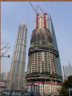
صورة توضح قلب المشروع في الدور ٥٢ وبناء الطوابق المنتهية
