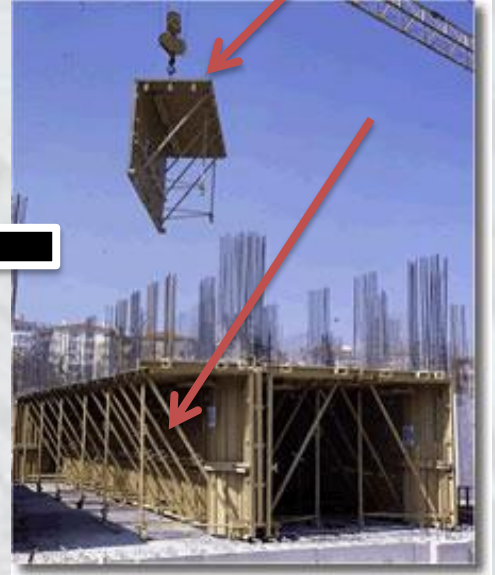
نقل الشدات بالأوناش ثم تثبيتها بدعامات للحصول على زاوية قائمة لصب الخرسانة.
