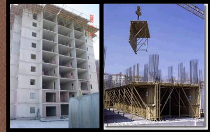
يتم استخدام الأوناش لرفع الشدات النفقية نتيجة لنقلها، ويتم رصها بجانب بعضها لصب الخرسانة
