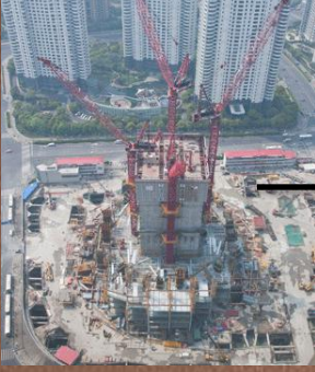
صوره توضيحية للشدات المنزلقة وقلب المشروع
