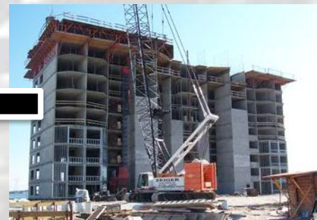
بعد الإنتهاء من صب الخرسانة في حوائط وأسقف الدور وتركها فترة لتتشك يتم فكها وتركيها في الدور الذي يليه لصب الخرسانة أيضا وهكذا .
