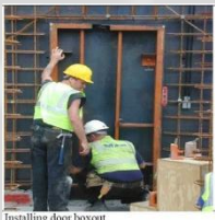
Installing door boxout
