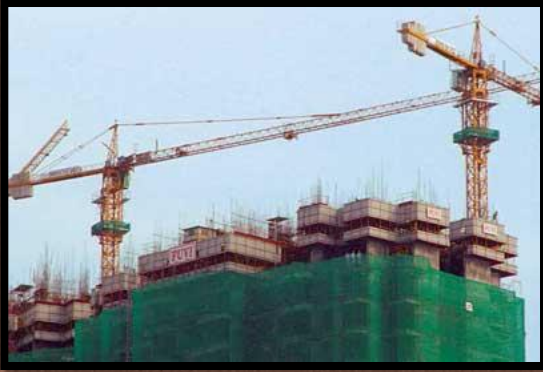
استخدام الشدات المنزلقة رأسياً في المباني المرتفعة
