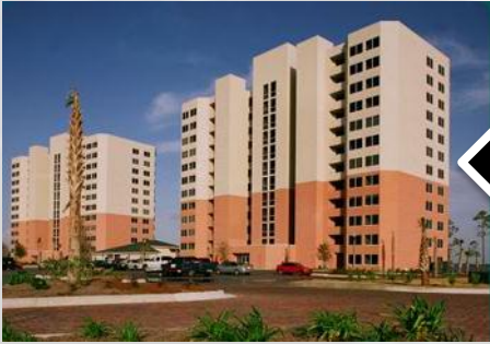
الشدات الأفقية أنتجت واجهات لها مديولة مكررة حيث أنها تستخدم في المباني ذات الصفة التكرارية.
