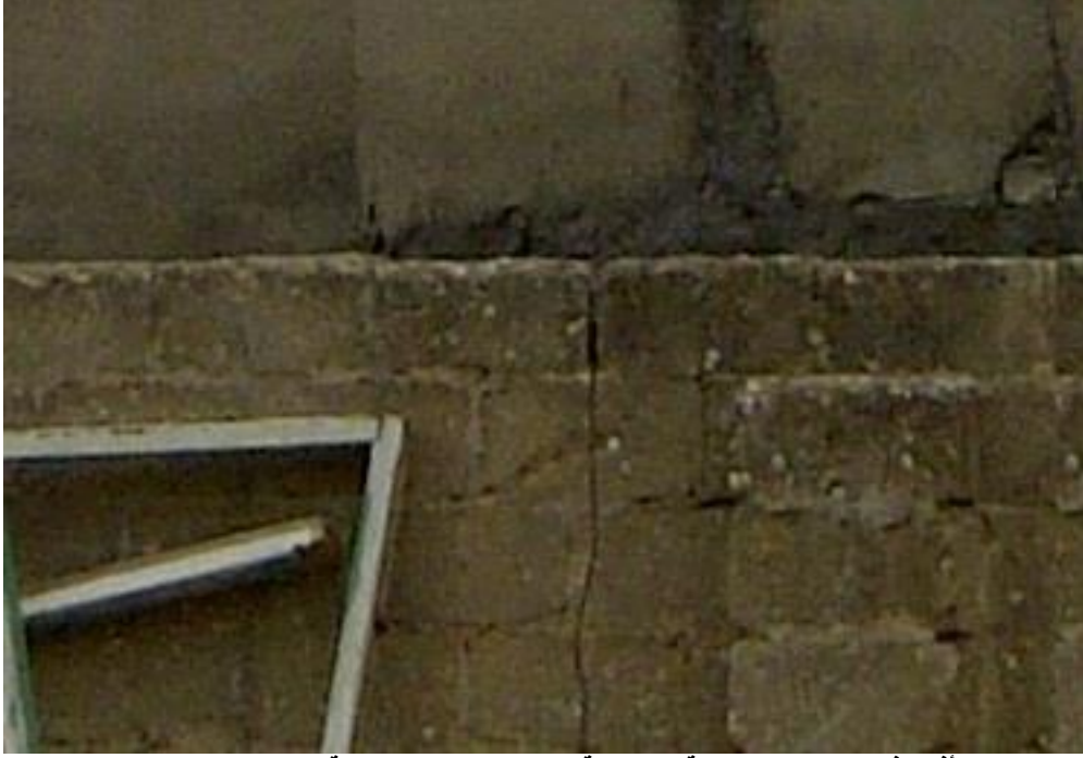
٦-٢ شرح أفقي في الجدار بين المونة الاسمنتية والبلوك وانفصال المونة عن البلوك
