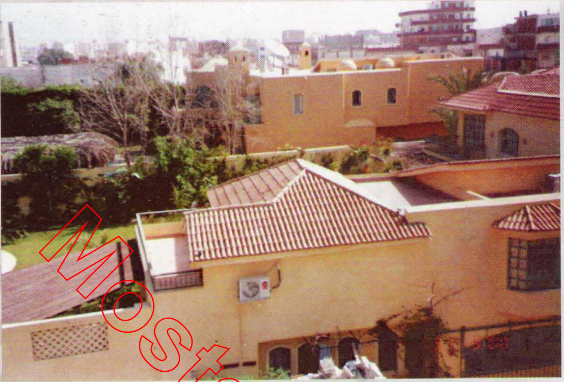
• كسوة الأسطح بالقرميد ، لاحظ ركوب القرميد واختلاف اتجاهه على مسطح كبير لتغطية غرفة كاملة.
