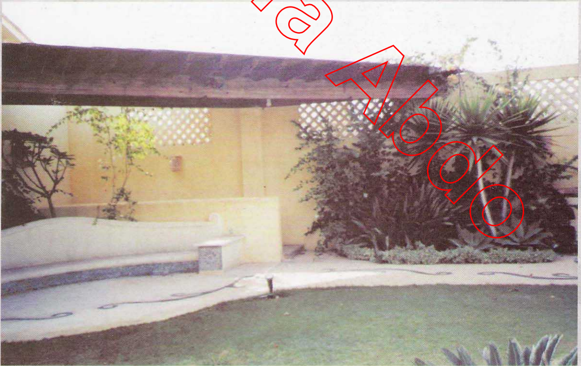
• استخدام الموزيكو في عمل مقاعد خارجية مع دمجها بالسيراميك .
