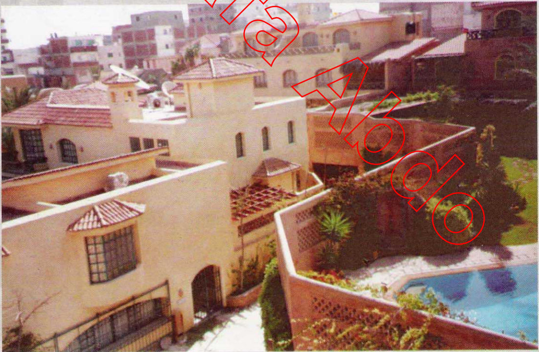
• كسوة الأسطح بالقرميد ، لاحظ ركوب القرميد واختلاف اتجاهه على مسطح كبير لتغطية غرفة كاملة.
